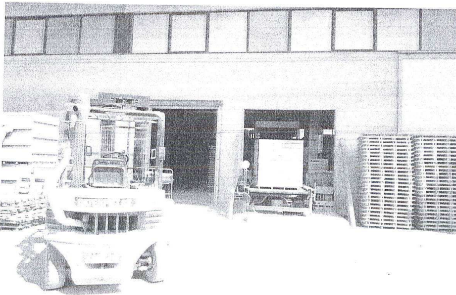
Foto N. 6 – Formazione di pallets con i blocchi di cemento e trasporto di essi nell'area di stoccaggio pronti per la vendita.
