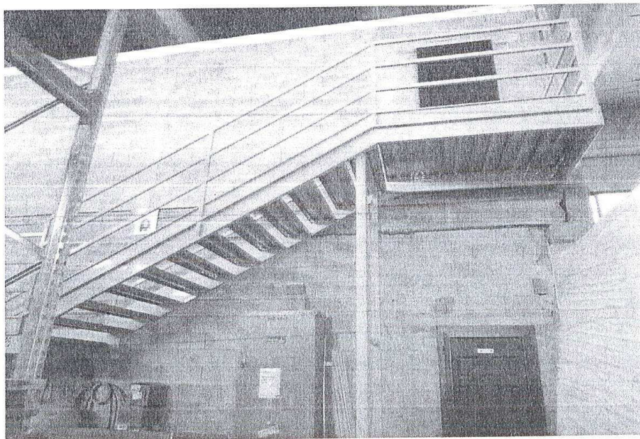
Foto N. 8 – blocco uffici/servizi - Costruito in blocchi di cemento al piano terra ci sono i servizi ed al piano primo gli uffici amministrativi. La scala ad una rampa è l'unico accesso per il primo piano.
