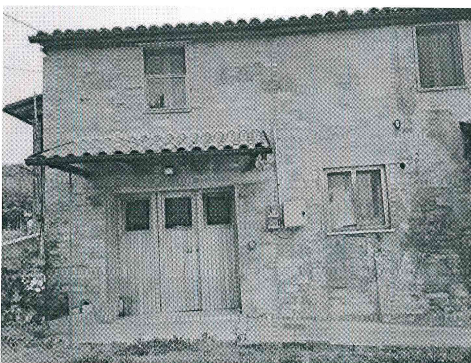
FOTO 1-LOTTO 1: ESTERNO DEL L'EDIFICIO DI CUI IL LABORATORIO FA PARTE – LATO SUD OVEST
