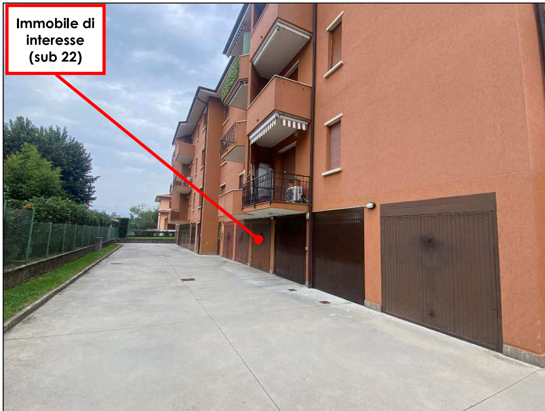
Foto n°27 – Cortile interno di accesso ai box auto al piano seminterrato
