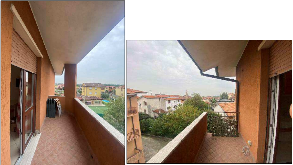
Foto n°20 e 21 – Balcone camera
