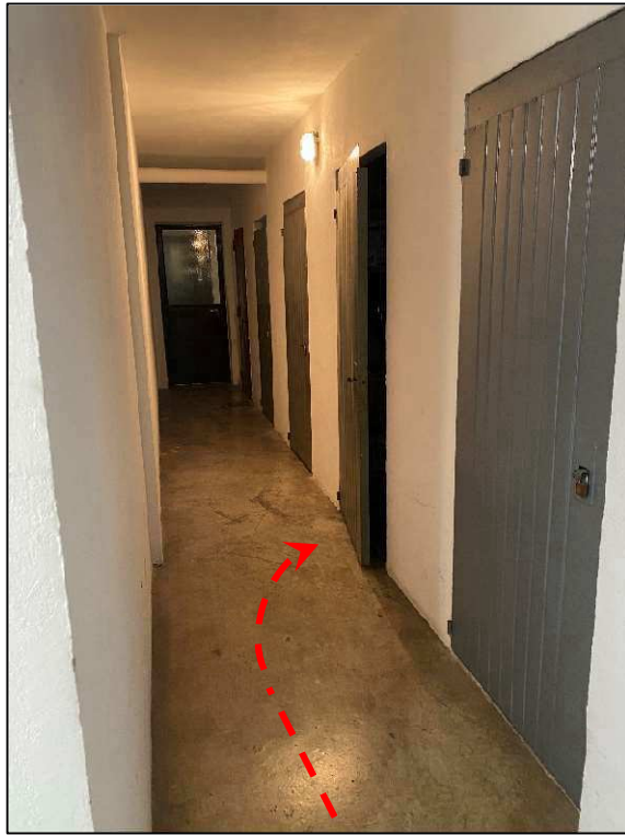
Foto n°25 – Cantina di pertinenza al piano seminterrato
