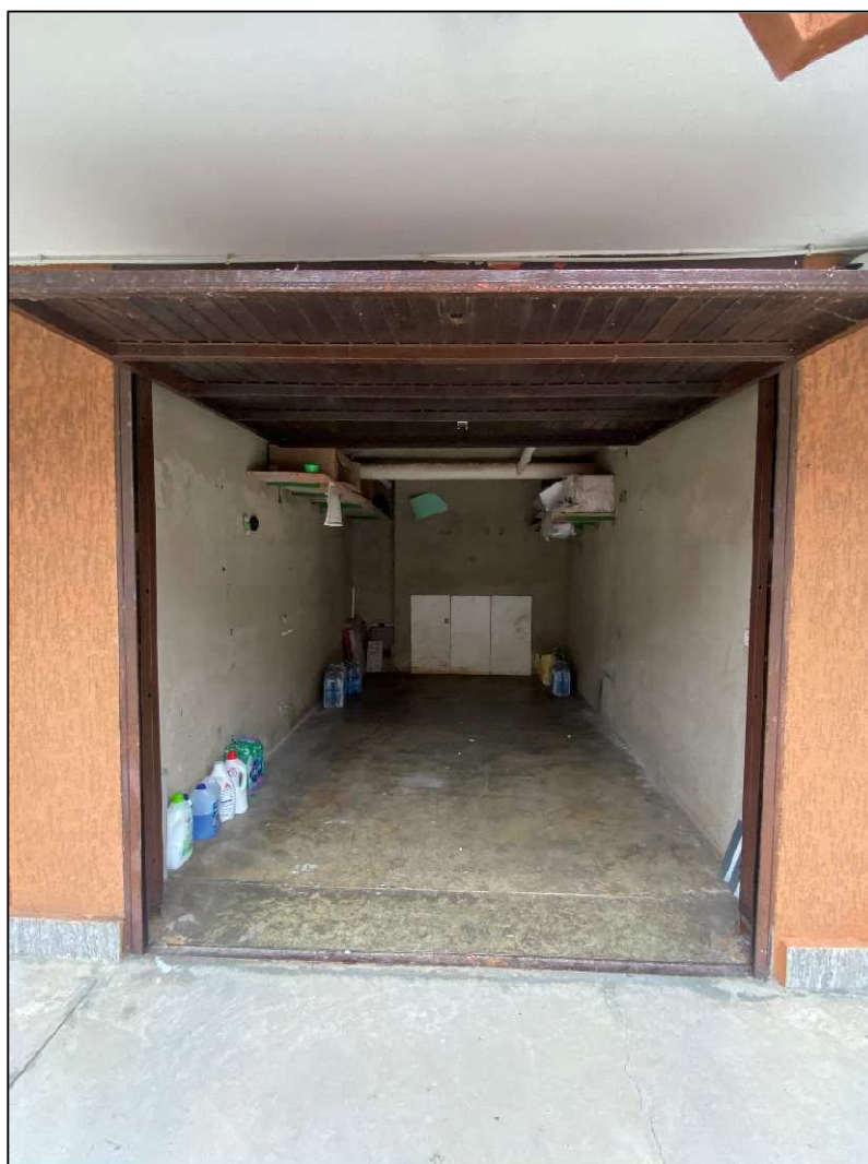
Foto n°29 – Box auto (sub 22) vista interno
