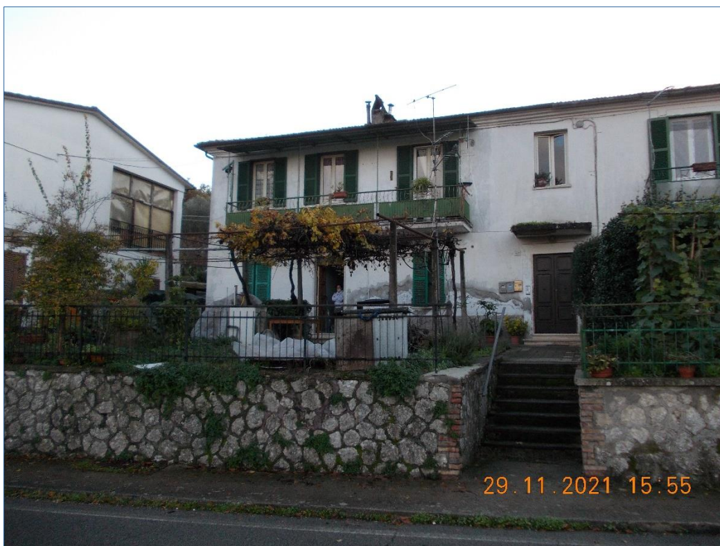
Foto 1. Vista da Via Scappia di Paglia/S.P. 150 , abitazione al piano terra
