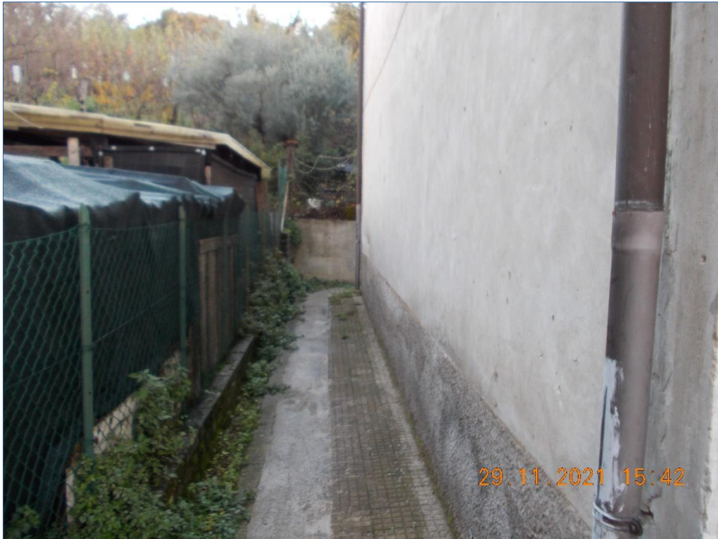
Foto 5. Vista lato sud-est fabbricato
