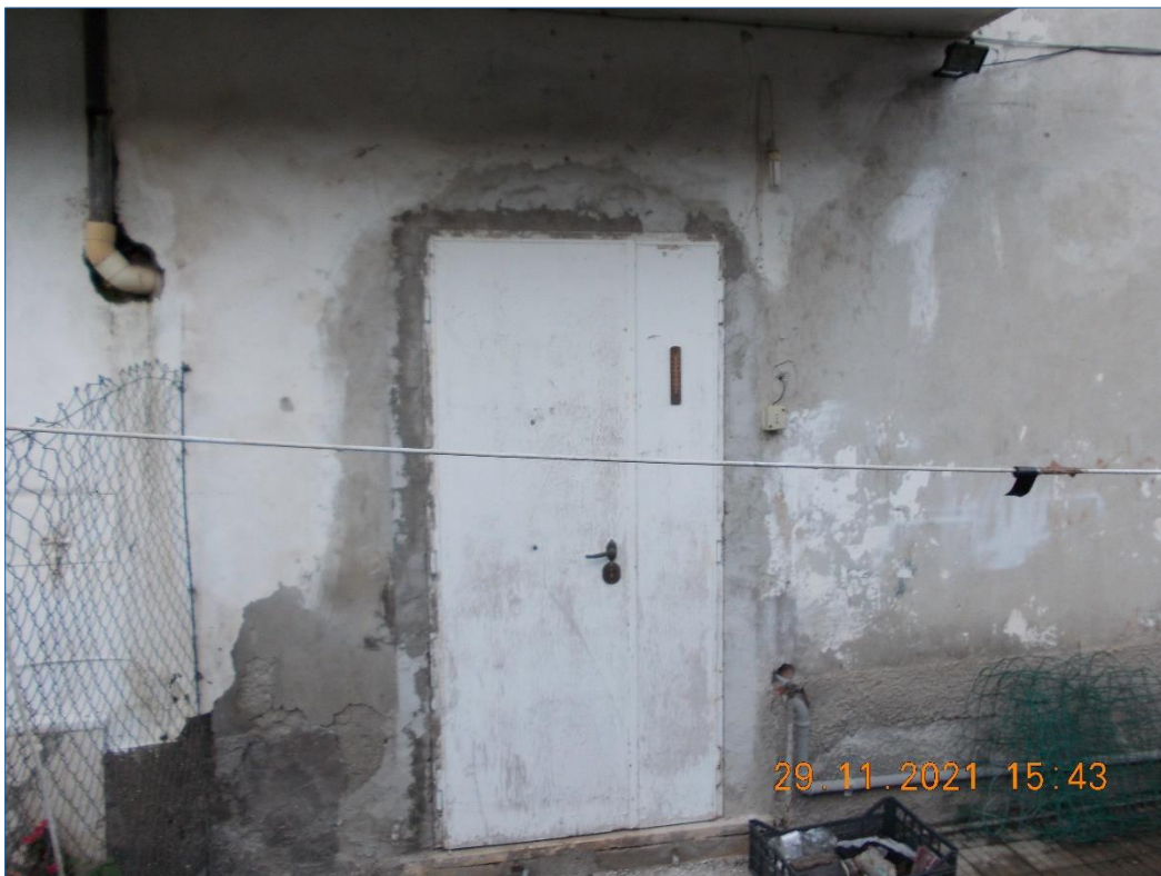
Foto 4. Ingresso esterno al vano deposito
