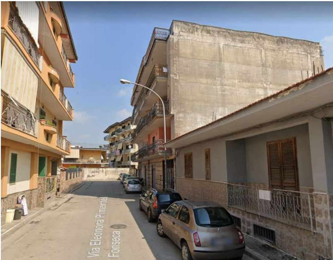
Foto 3: via Fonseca a Carditello: a dx il fabbricato di quattro piani f.t. e copertura piana.
