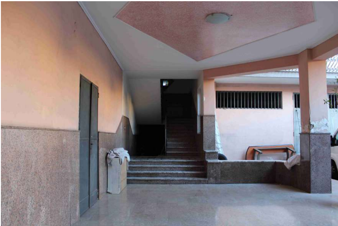
Foto 9: gradini di accesso al vano scala, dal piano terra del fabbricato.
