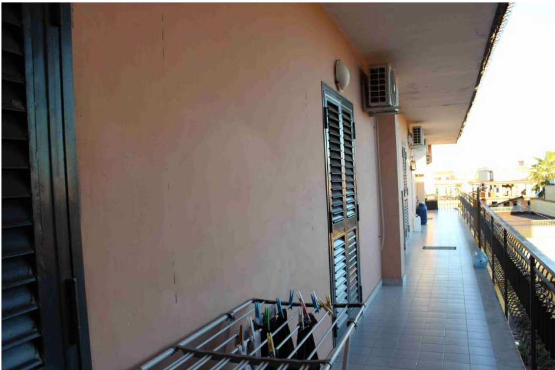
Foto 24: balcone esposto a sud, in parte in comune ai due appartamenti del terzo piano.
