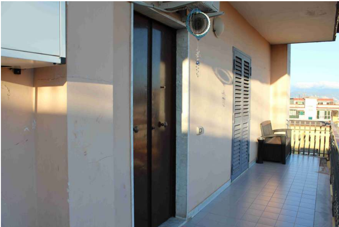
Foto 25: porta in ferro di accesso all'appartamento (sub 106), dal balcone comune.
