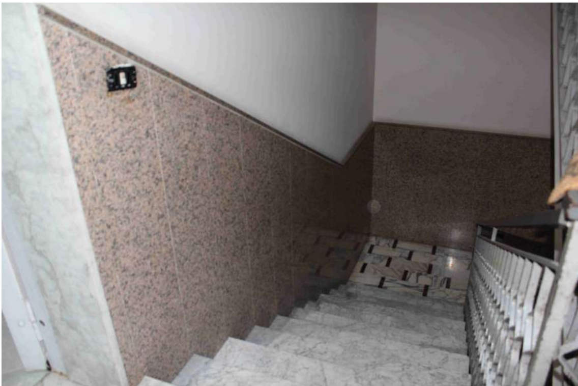
Foto 10: rampa del vano scala che conduce al piano terzo, con rivestimenti in marmo.
