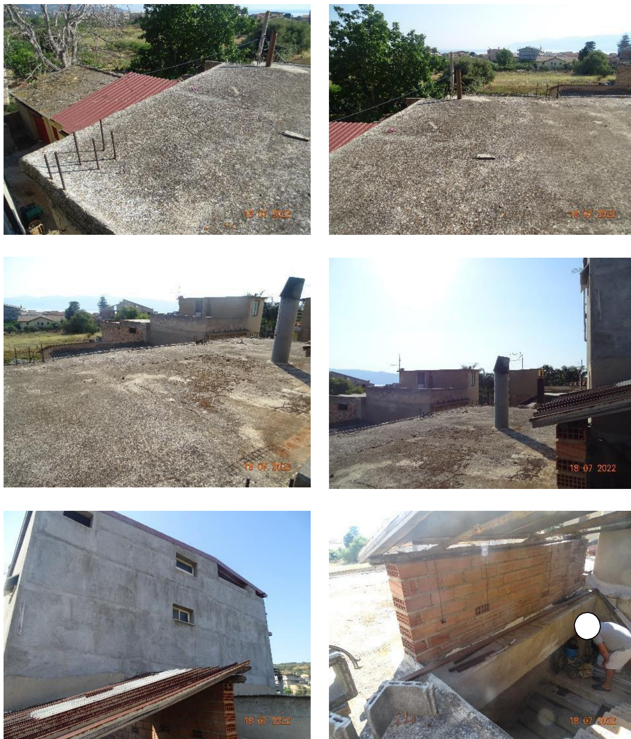
Figura 26: Copertura del fabbricato
