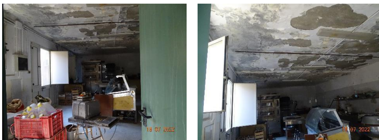
Figura 21: Subalterno 1 (piano terra) – laboratorio
