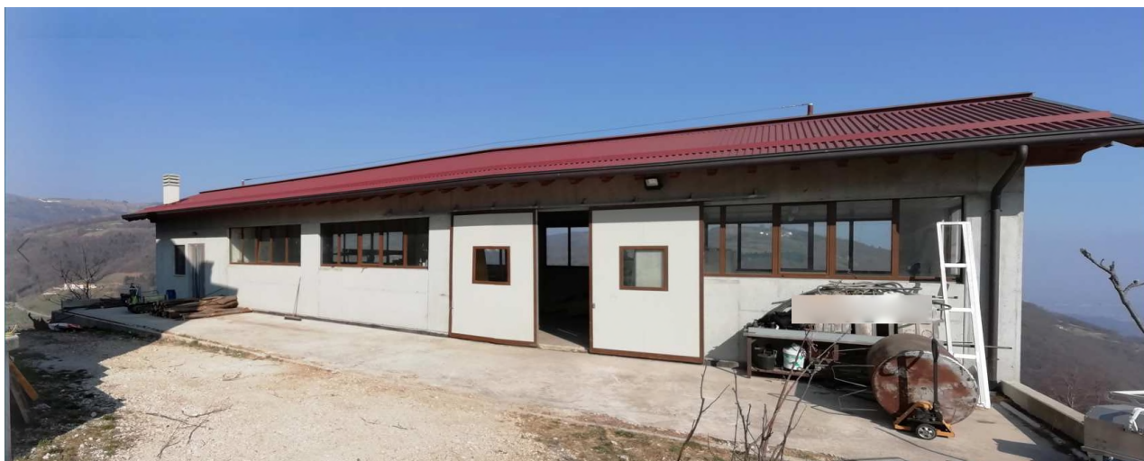
Vista ovest – piano terra
