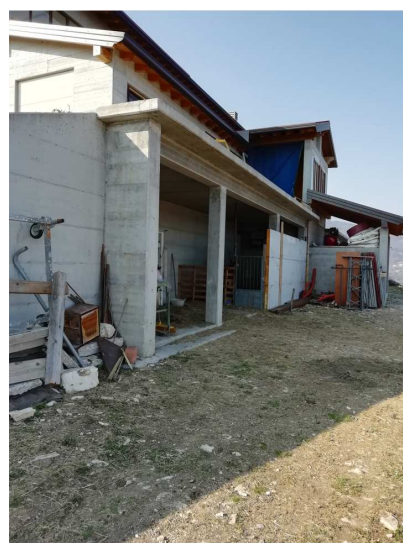
Vista est – locali abusivi
