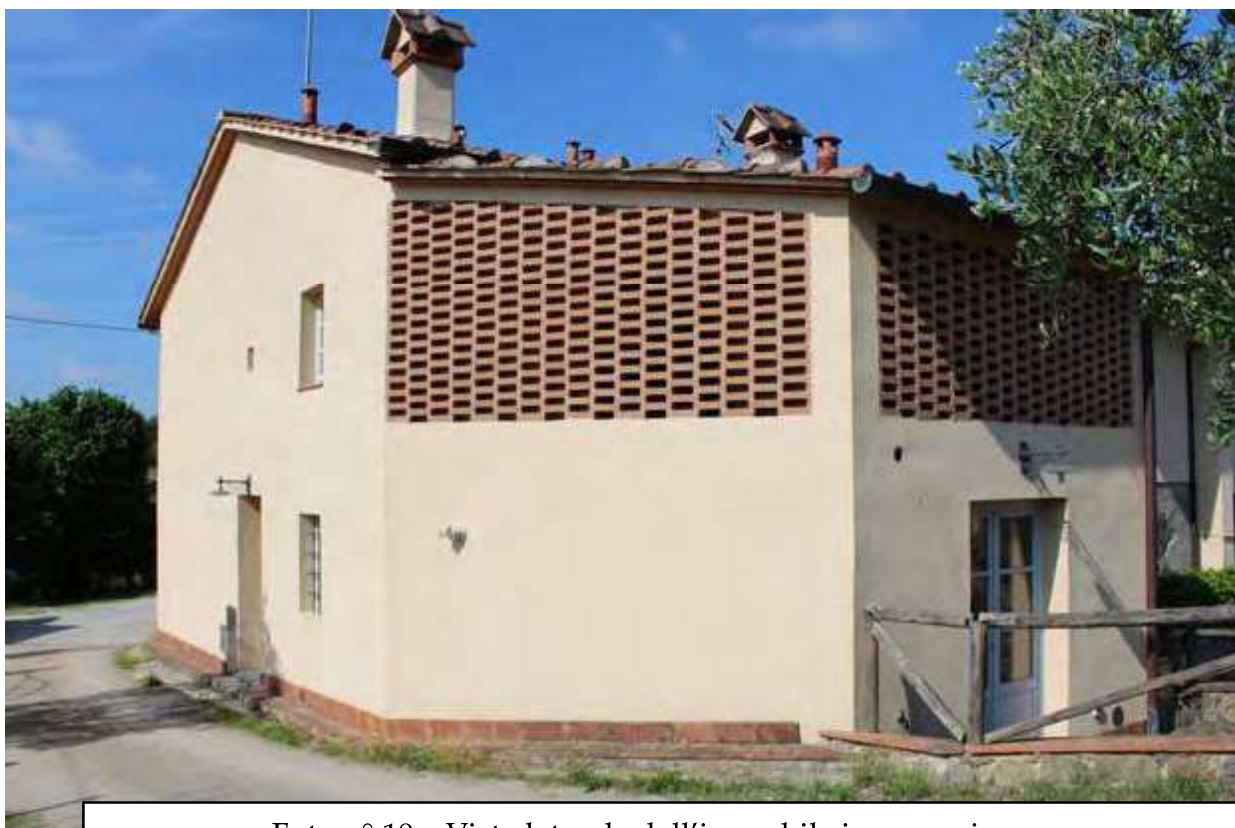
Foto n° 10 – Vista laterale dell'immobile in esecuzione
