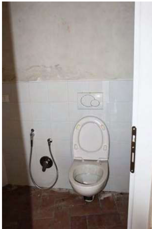
Foto n° 29 – Bagno/wc al PT
