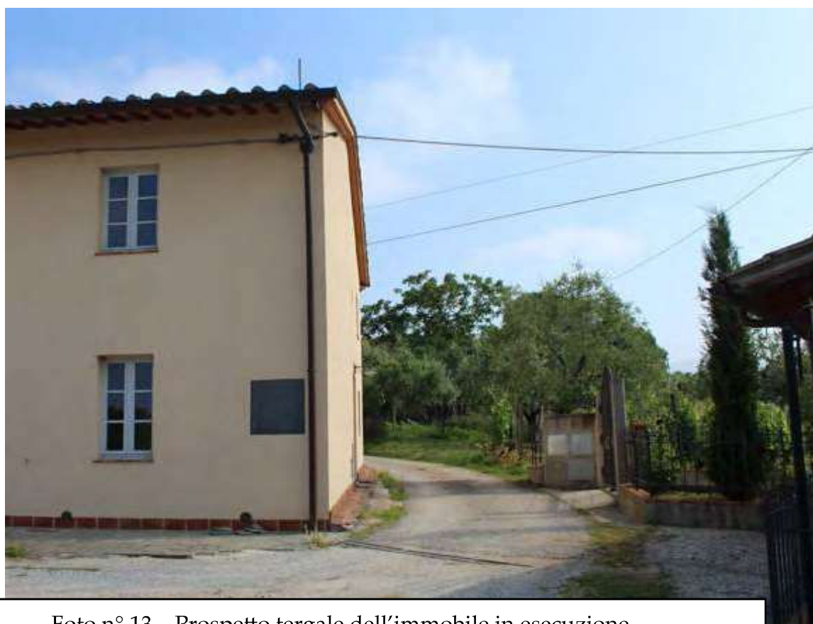
Foto n° 13 – Prospetto tergale dell'immobile in esecuzione
