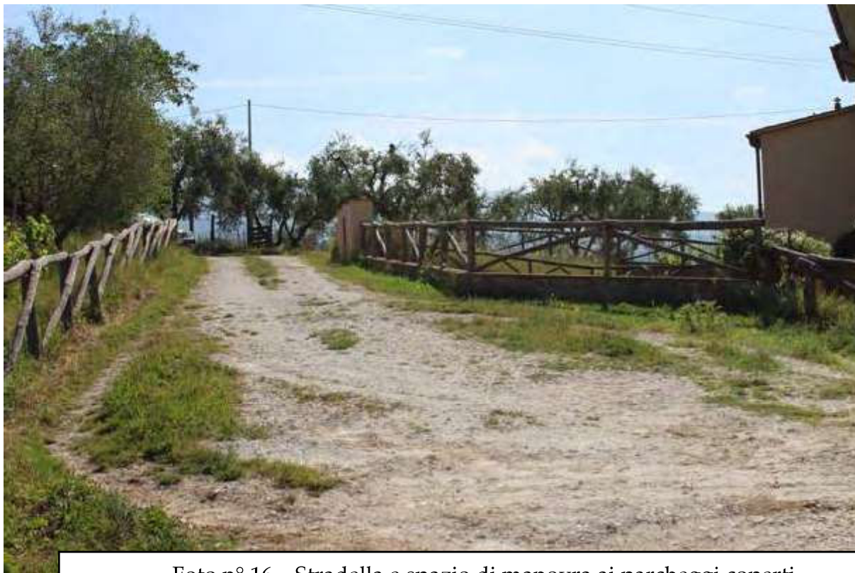
Foto n° 16 – Stradella e spazio di manovra ai parcheggi coperti
