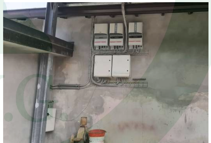
centraline - inverter impianto fotovoltaico
