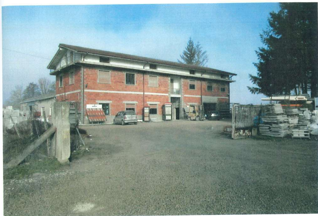
2 – VISTA GLOBALE PROSPETTO SUD - EST
