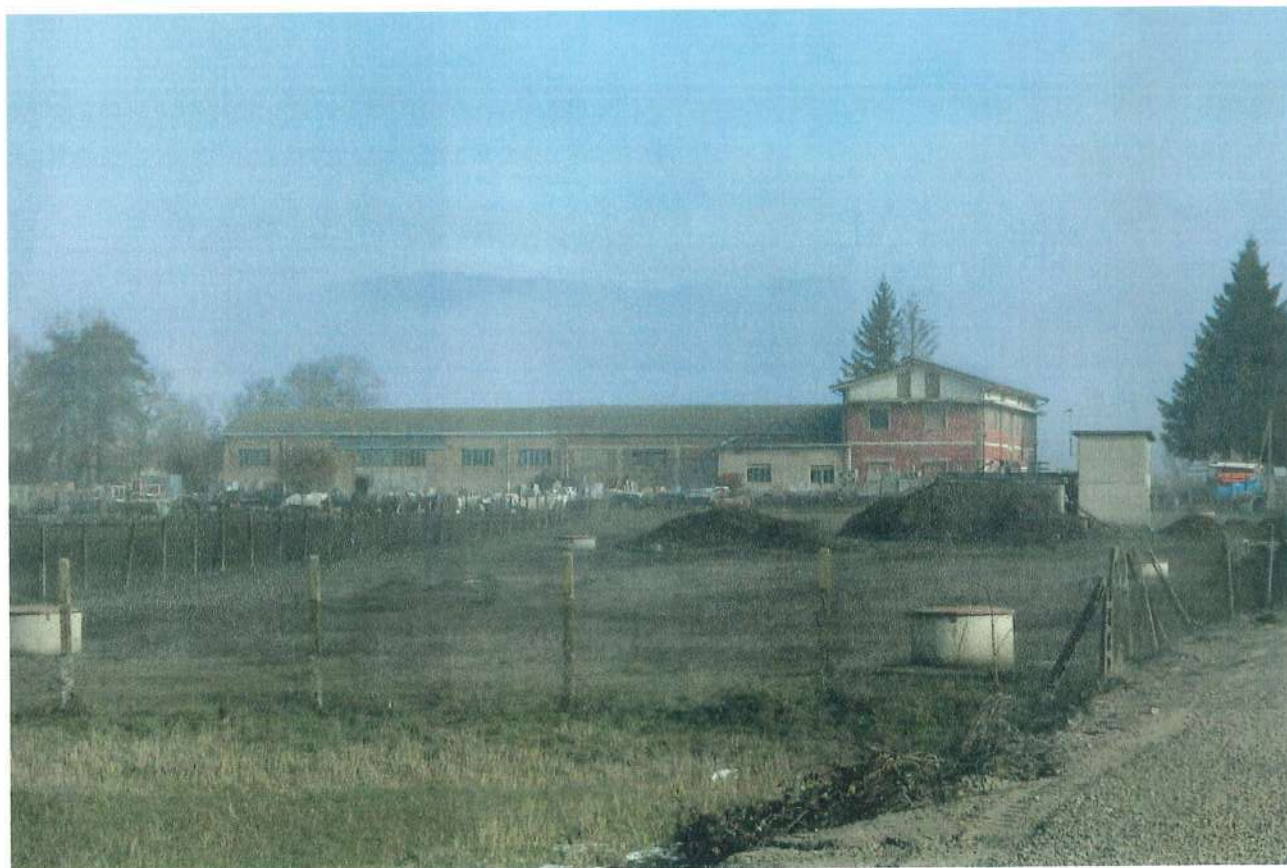
1 – VISTA GLOBALE DEL COMPLESSO IMMOBILIARE
