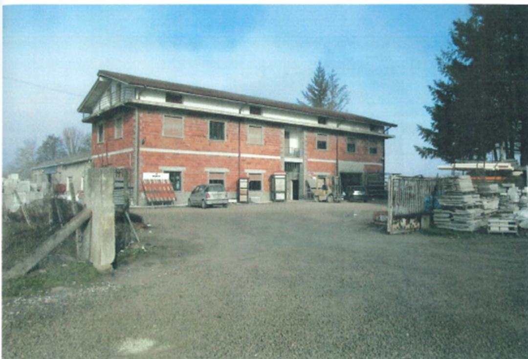
2 – VISTA GLOBALE PROSPETTO SUD - EST
