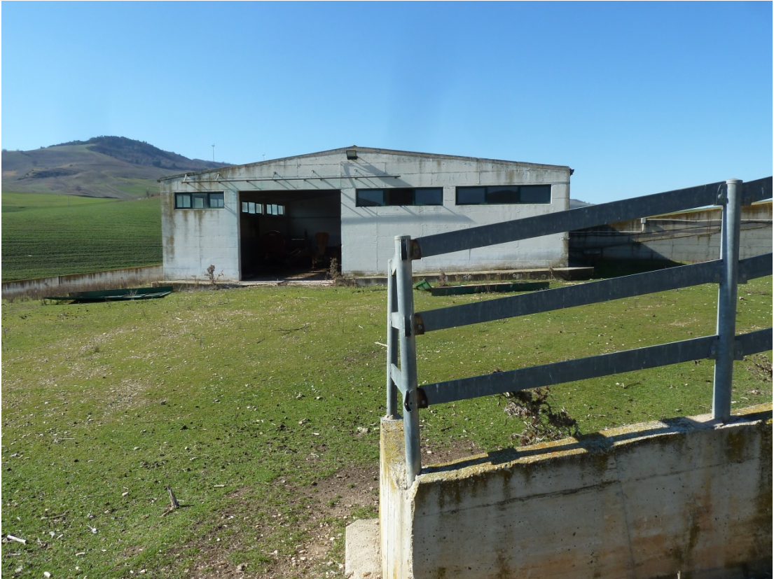
FOTO 7 – edificio identificato in catasto fabbricati come p.lla 361 sub 1 del fg 4. Non è in regola con gli strumenti urbanistici
