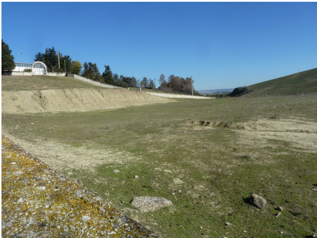
FOTO 5 – Ampia veduta di parte delle superfici delle p.lle 364-14-15-16 e 18 recintate e destinate ad ovile esterno.
