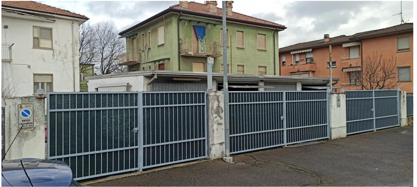
VISTA BOX DA AREA INTERNA
