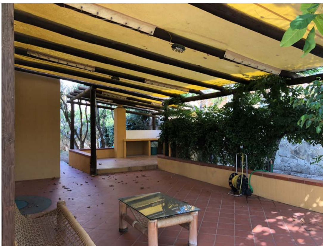
Foto n.15 – Piano Terra – Pergolato retrostante abitazione
