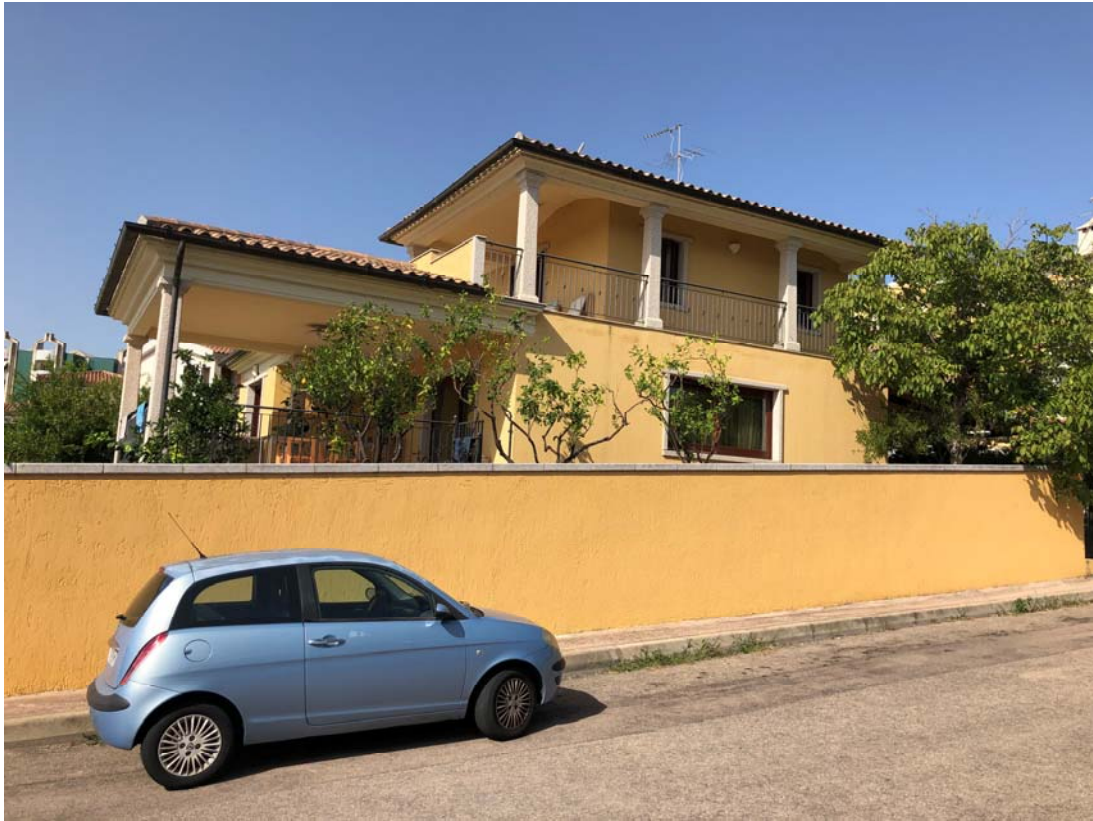
Foto n.16 – Vista esterna lato est
