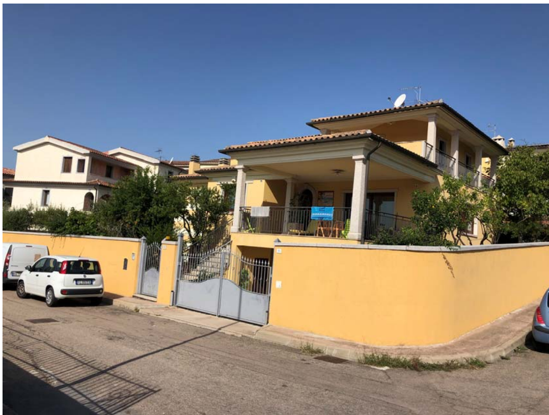
Foto n.3 – Fronte Sud-Est – Facciata esterna proprietà
