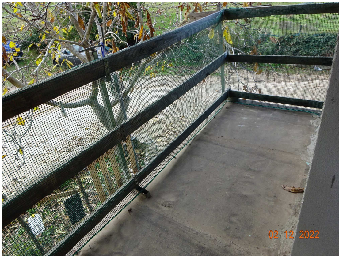
foto 17 – Sub. 5 (piano terra): balcone camera n° 2
