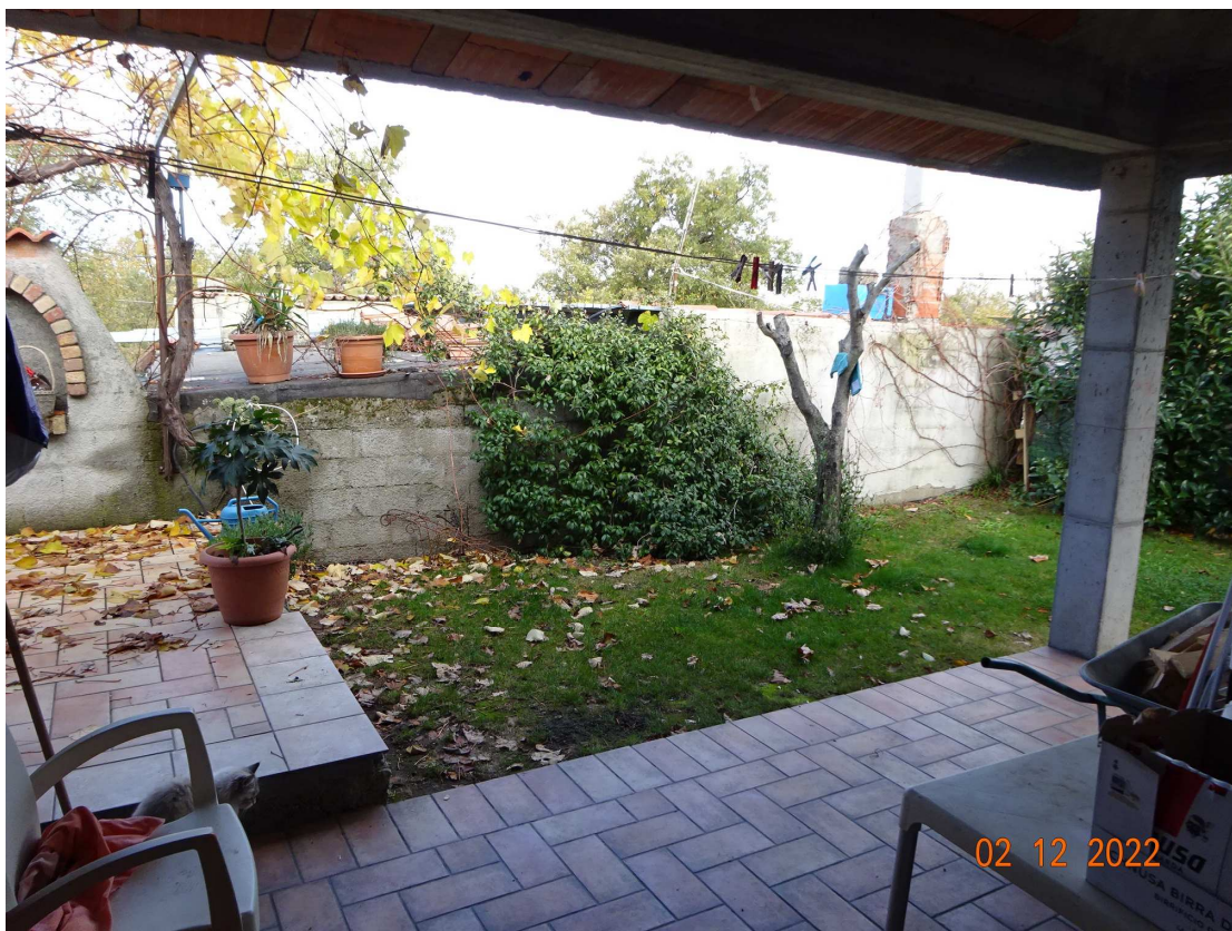
foto 13 – Sub. 5 (piano terra): veranda soggiorno sul lato nord
