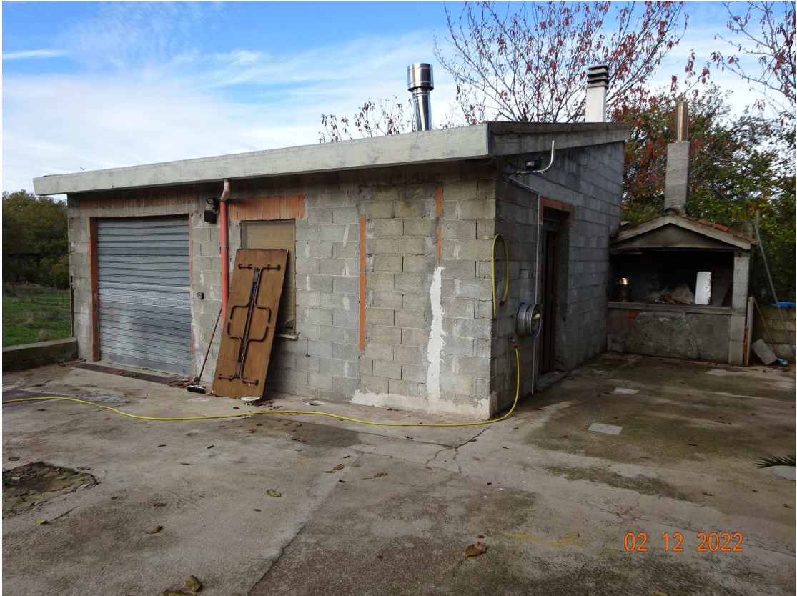
foto 21 – Legnaia-garage all'angolo nord-ovest
