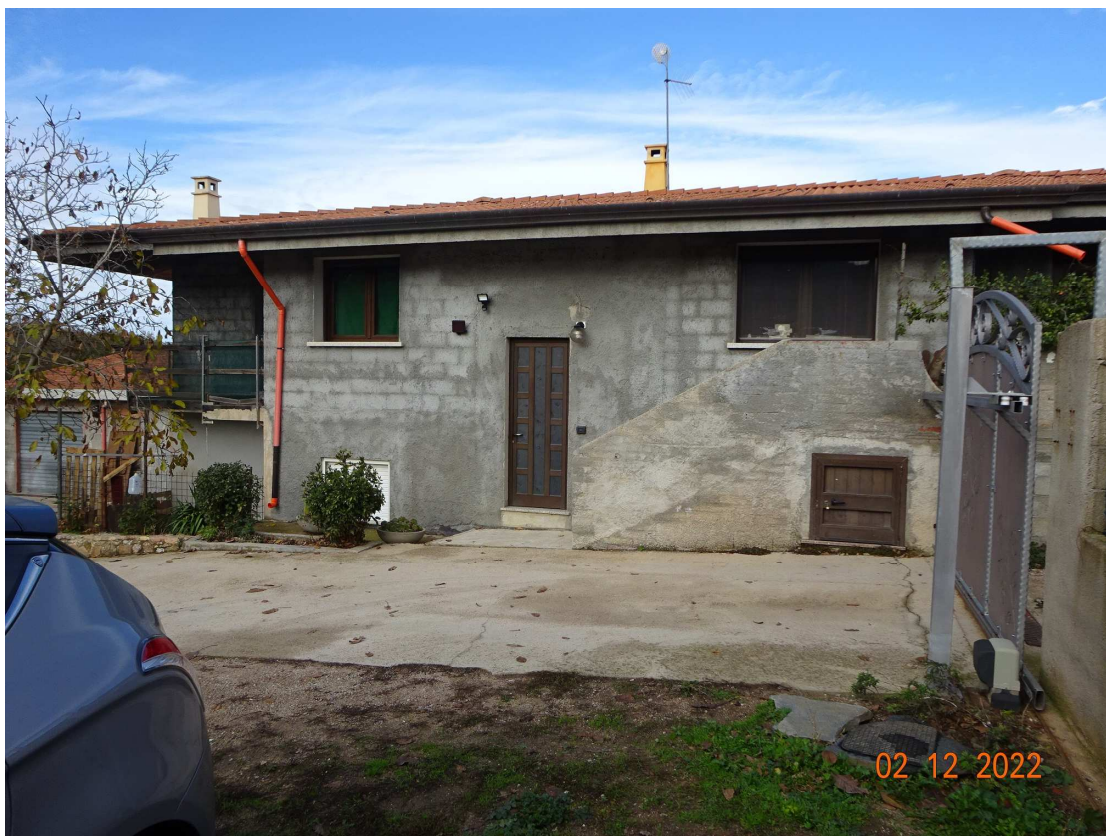
foto 1 – Esterno dell'edificio sul lato sud
