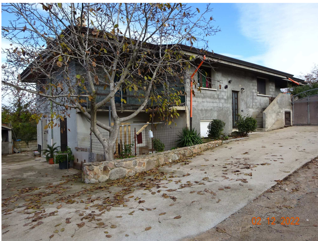
foto 2 – Esterno dell'edificio visto dall'angolo sud-ovest
