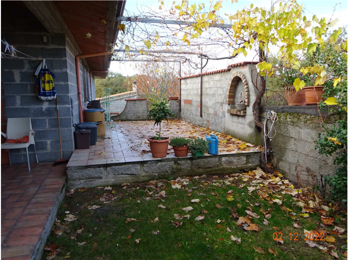
foto 3 – Esterno dell'edificio sul retro lato nord
