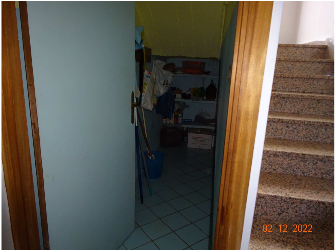
foto 9 – Sub. 6 (piano seminterrato): sottoscala e attacco scale
