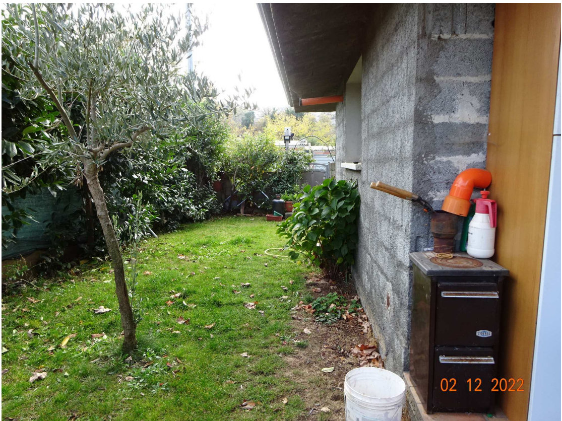
foto 4 – Esterno dell'edificio sul lato est
