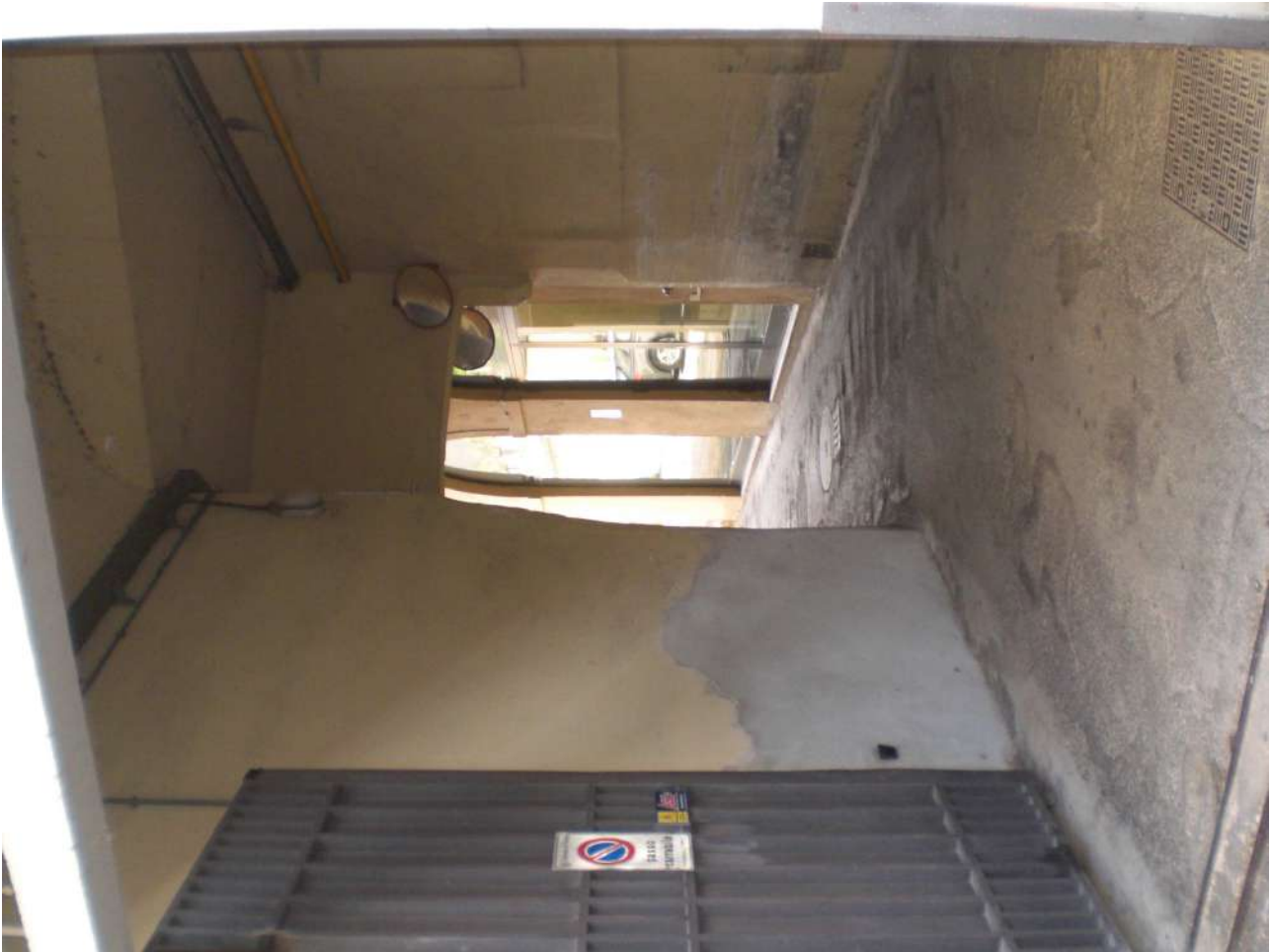
Foto 2 : galleria d'ingresso carrabile e pedonale .
