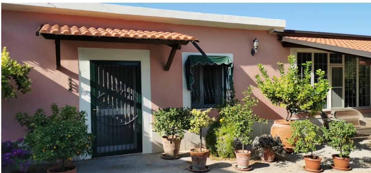
Figura 11: immobile in Lucera (FG) c.da Conocchiola snc (viste esterne)
