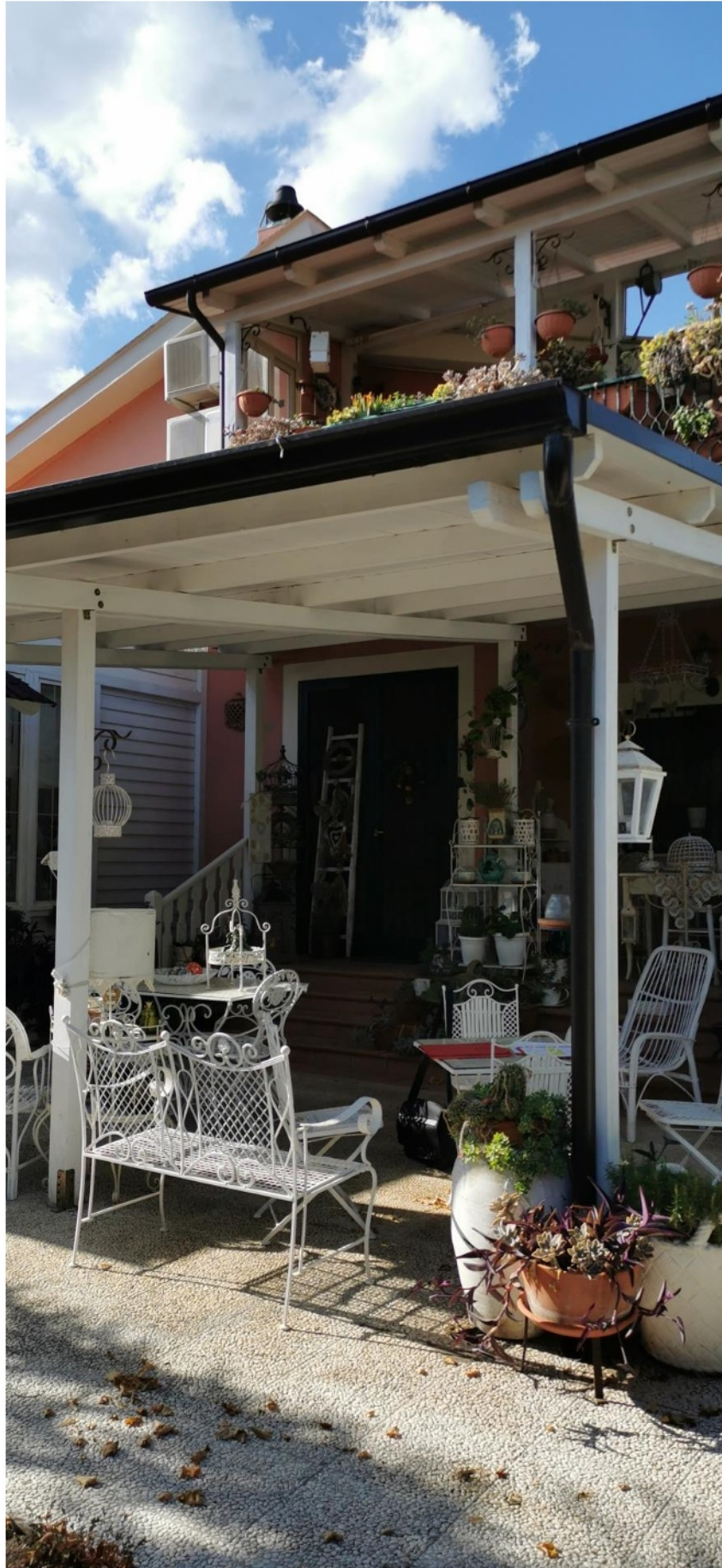
Figura 15: immobile in Lucera (FG) c.da Conocchiola snc (viste esterne)
