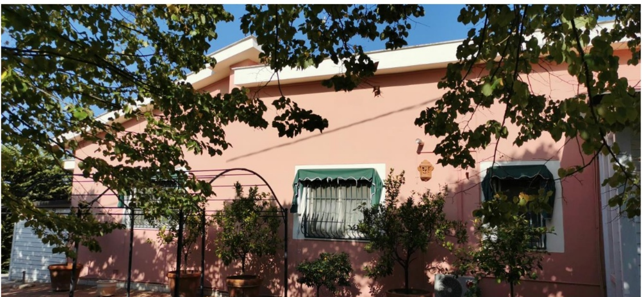
Figura 19: immobile in Lucera (FG) c.da Conocchiola snc (viste esterne)
