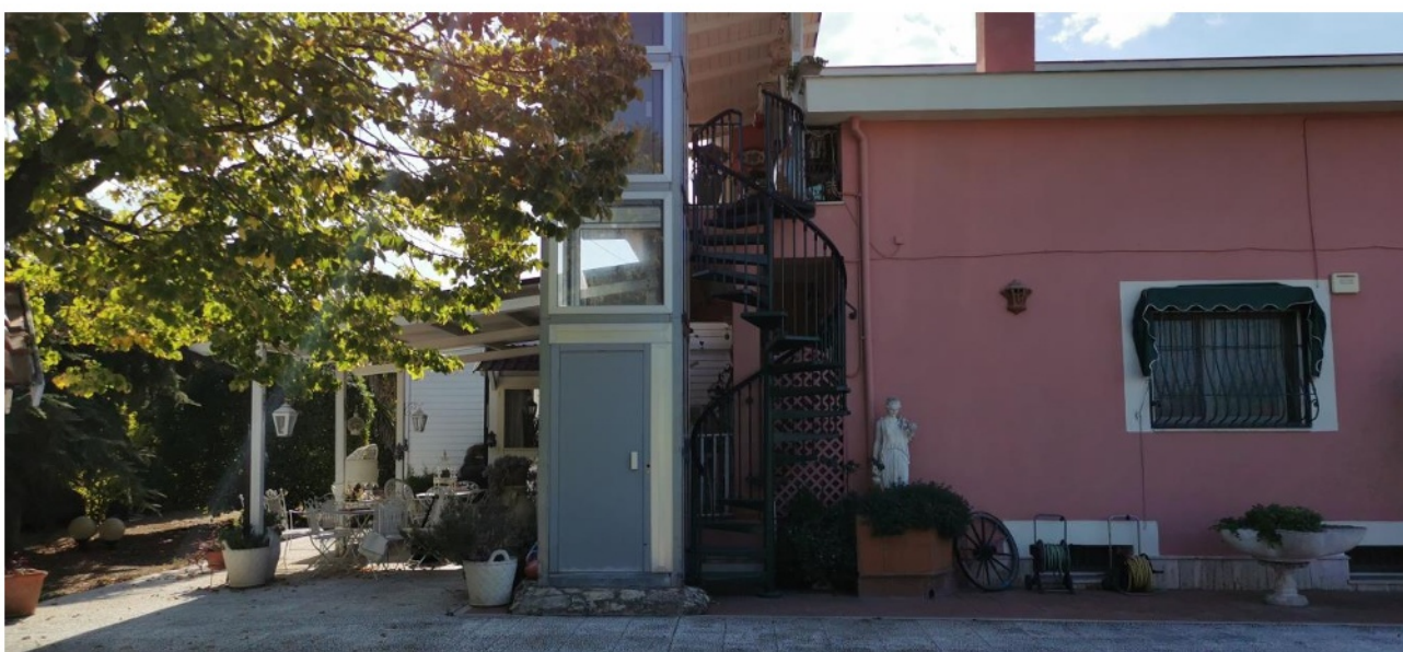
Figura 13: immobile in Lucera (FG) c.da Conocchiola snc (viste esterne)
