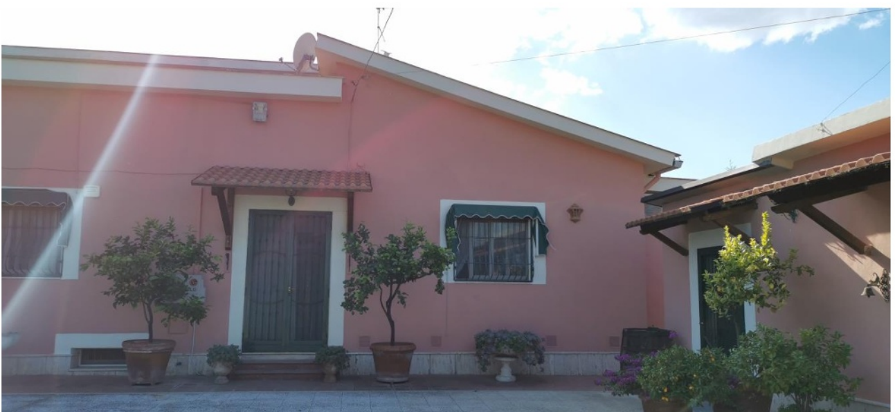
Figura 12: immobile in Lucera (FG) c.da Conocchiola snc (viste esterne)
