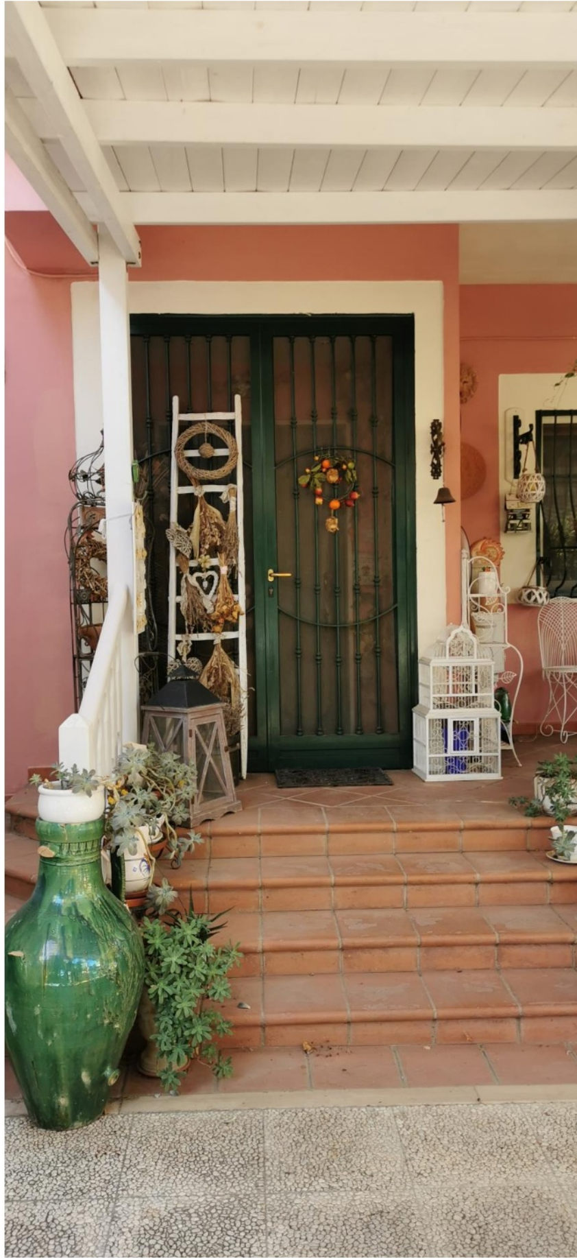
Figura 20: immobile in Lucera (FG) c.da Conocchiola snc (ingresso appartamento piano rialzato)
