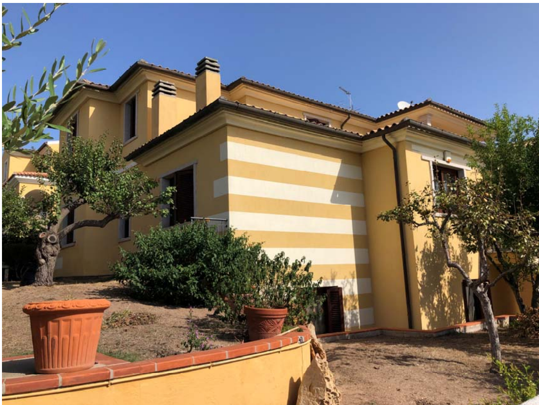
Foto n.17 – Vista esterna scorcio Sud-Ovest
