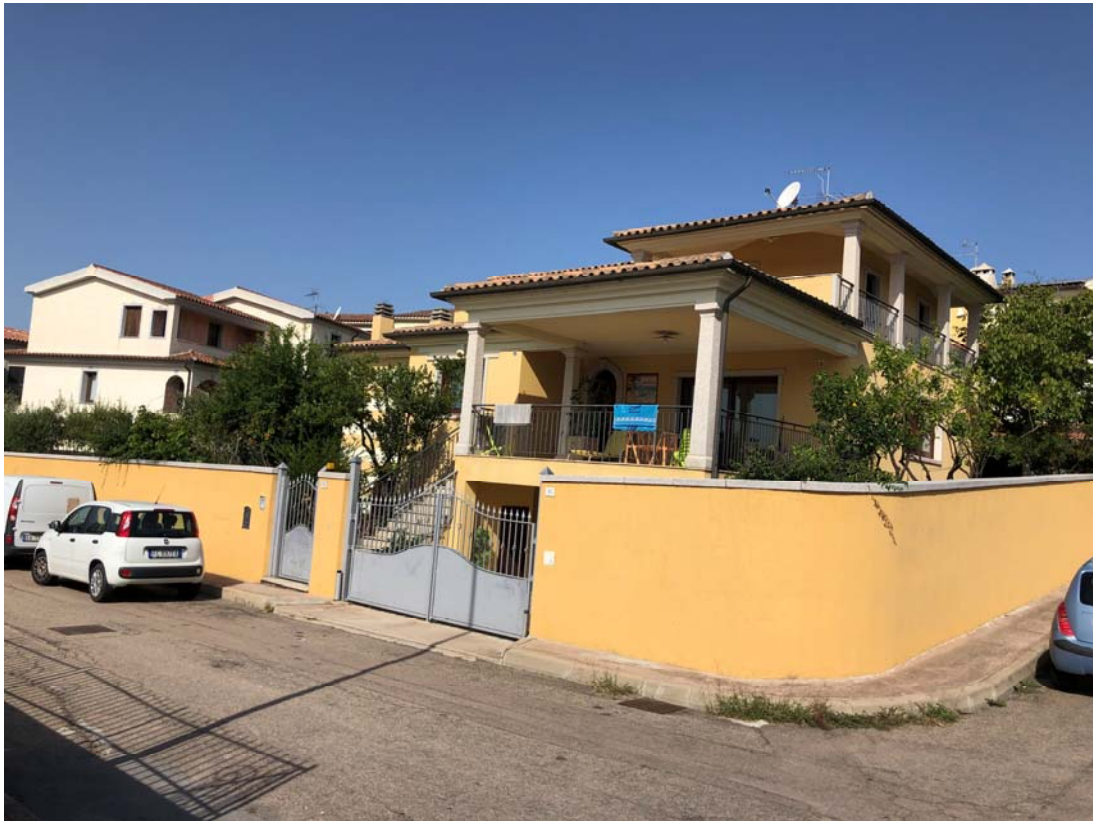
Foto n.3 – Fronte Sud-Est – Facciata esterna proprietà
