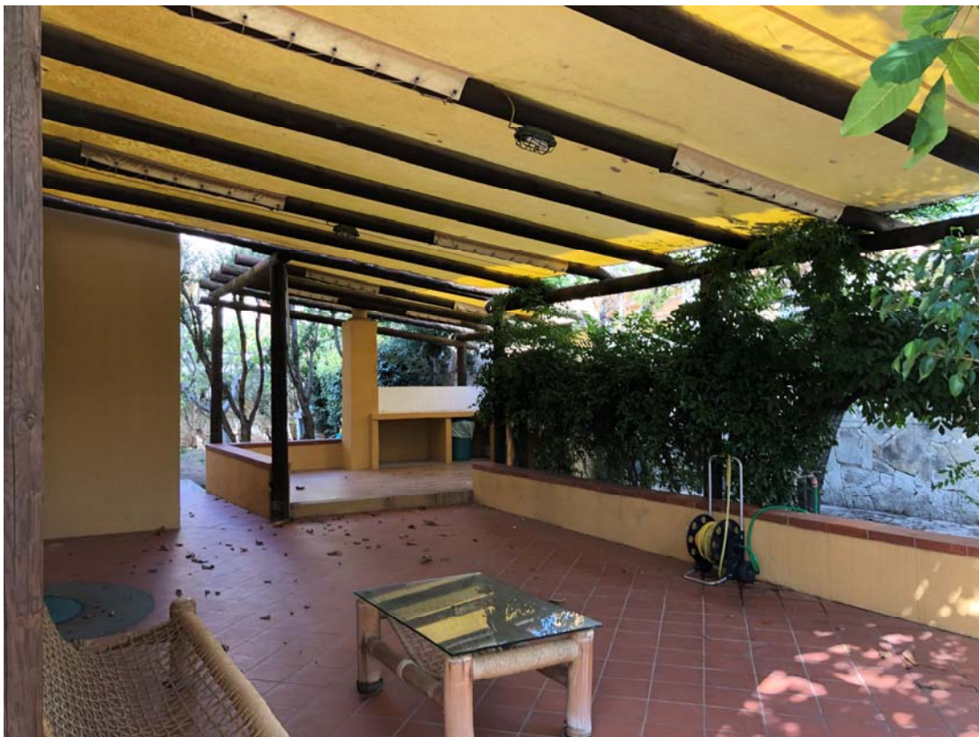
Foto n.15 – Piano Terra – Pergolato retrostante abitazione
