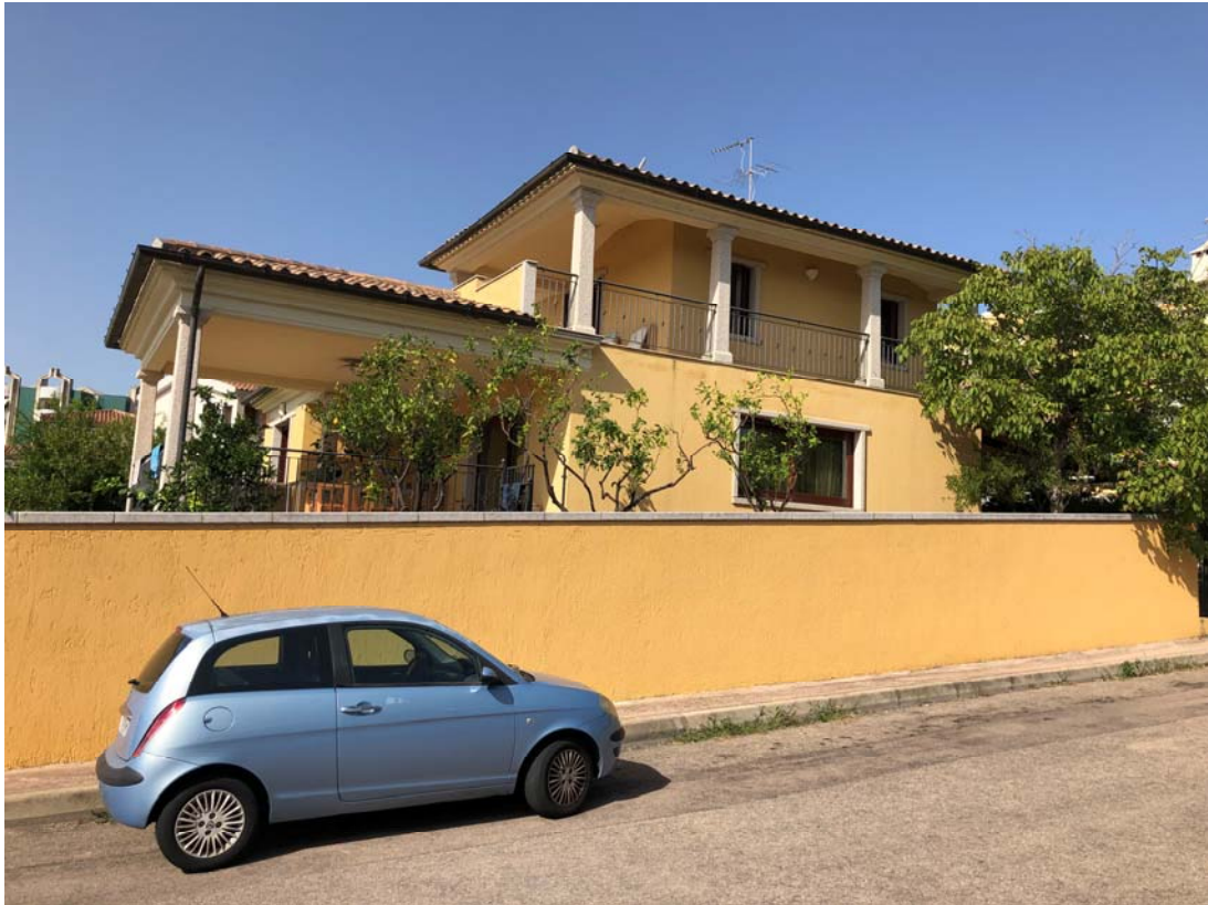
Foto n.16 – Vista esterna lato est
