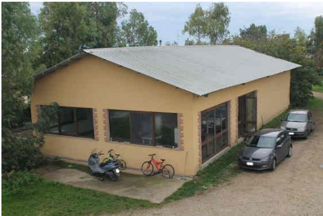
Foto -139 – Vista dall'alto del Club House
