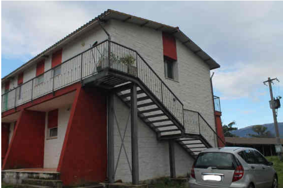
Foto 75 – Vista laterale dell'Edificio
