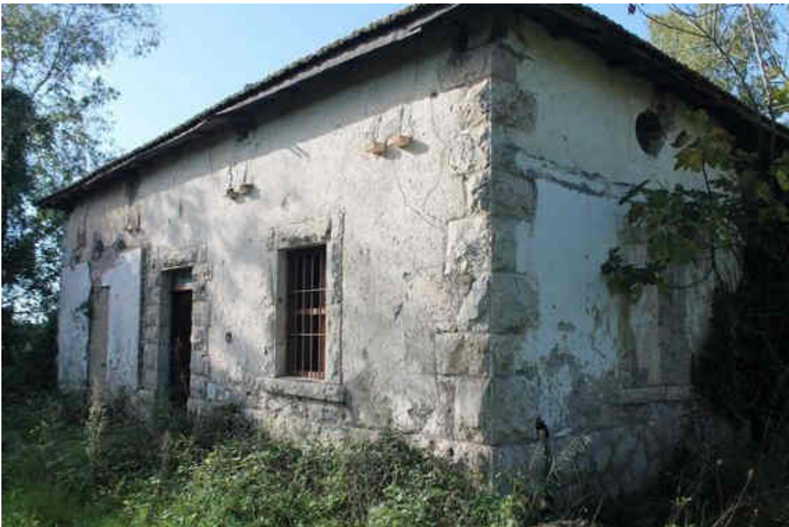
Foto 126 – Vista Laterale dell'Edificio
