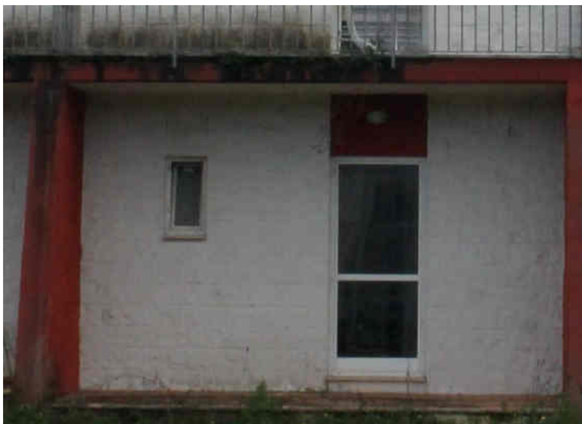
Foto 78 – il Portoncino di ingresso
