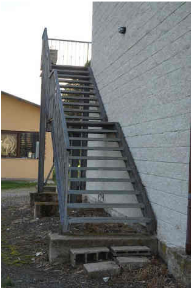
Foto 88 – la Scala in Ferro da cui si accede al Ballatoio/ Balcone del Piano Primo
