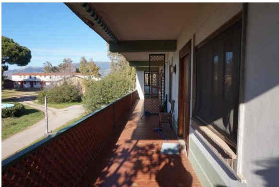
Foto 40 – il Balcone/ Ballatoio su cui si affacciano gli Ingressi dei Sub. 3 e Sub.4
