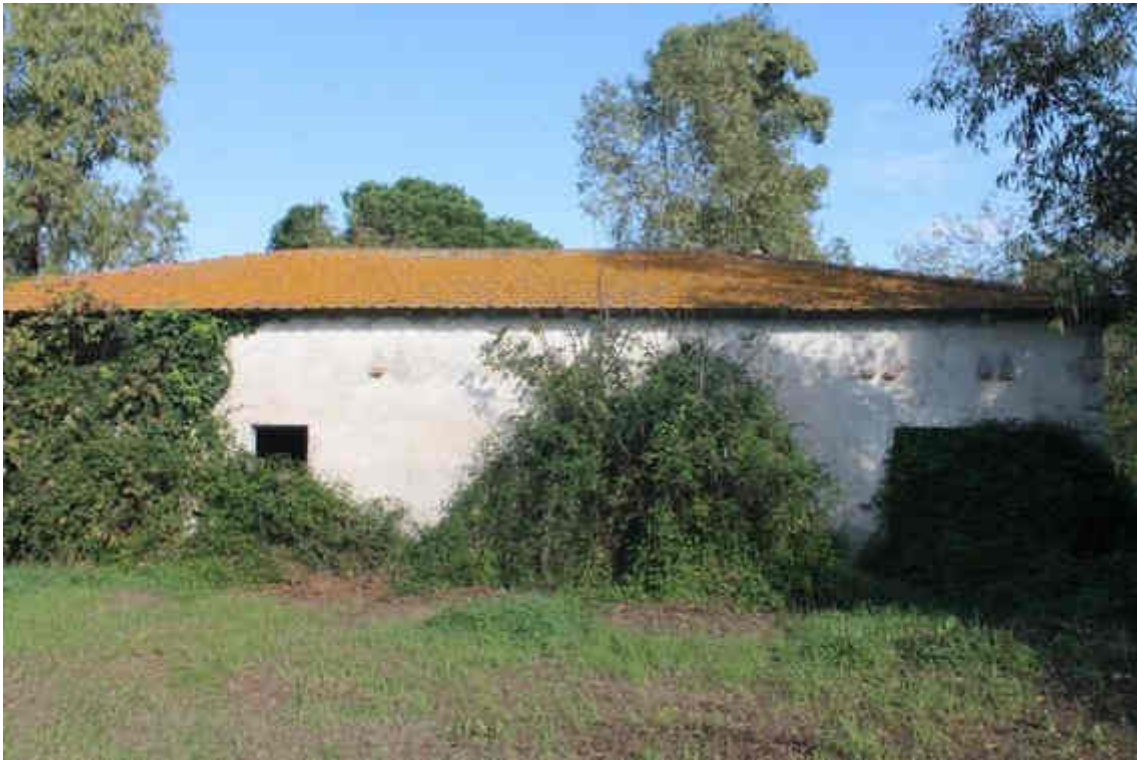
Foto 127 – Vista laterale dell'Edificio
