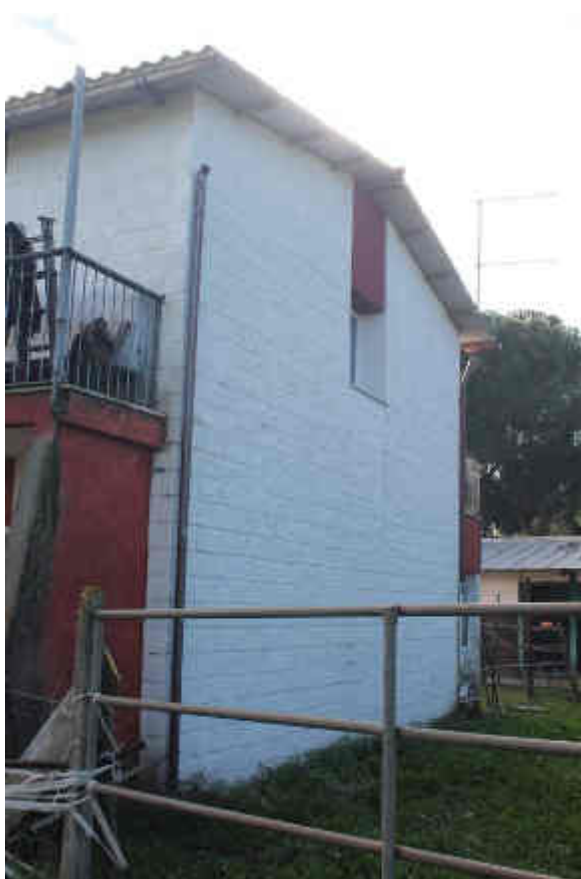
Foto 77 – Vista laterale dell'Edificio
