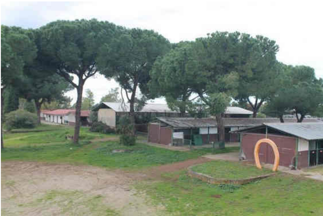
Foto 160 – Vista di insieme delle Stalle, del Fienile e delle Scuderie
