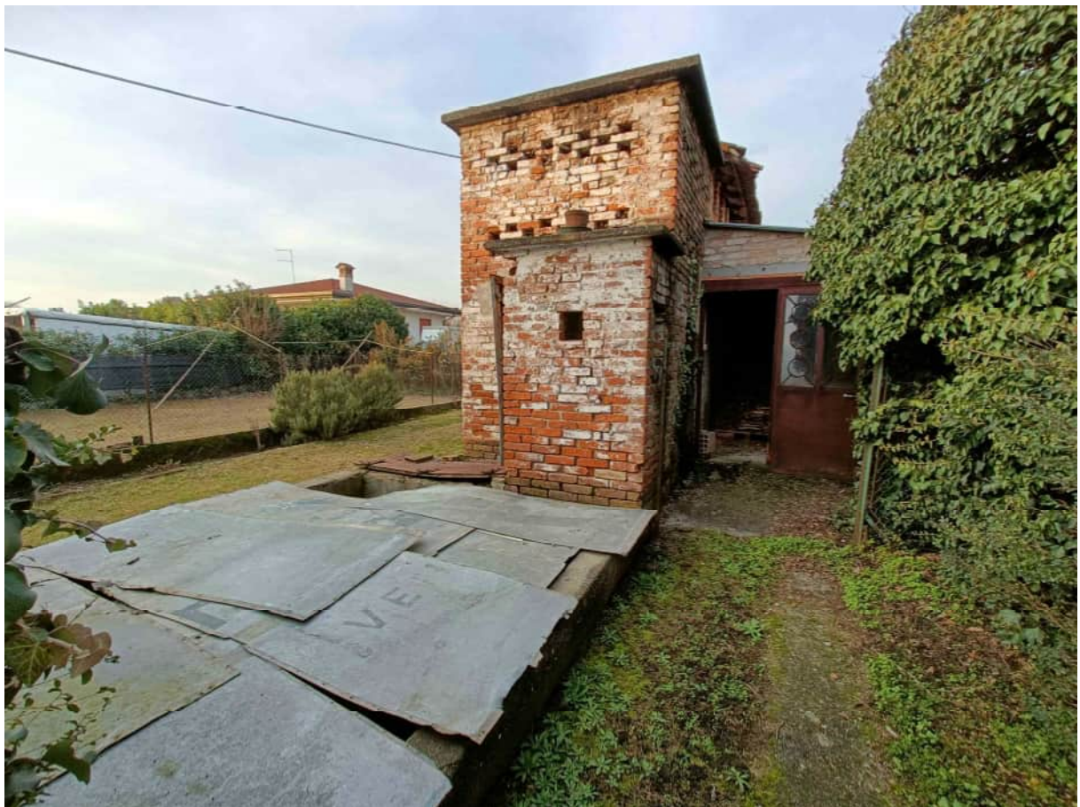
Foto 60: Fabbricato accessorio – Prospetto nord
