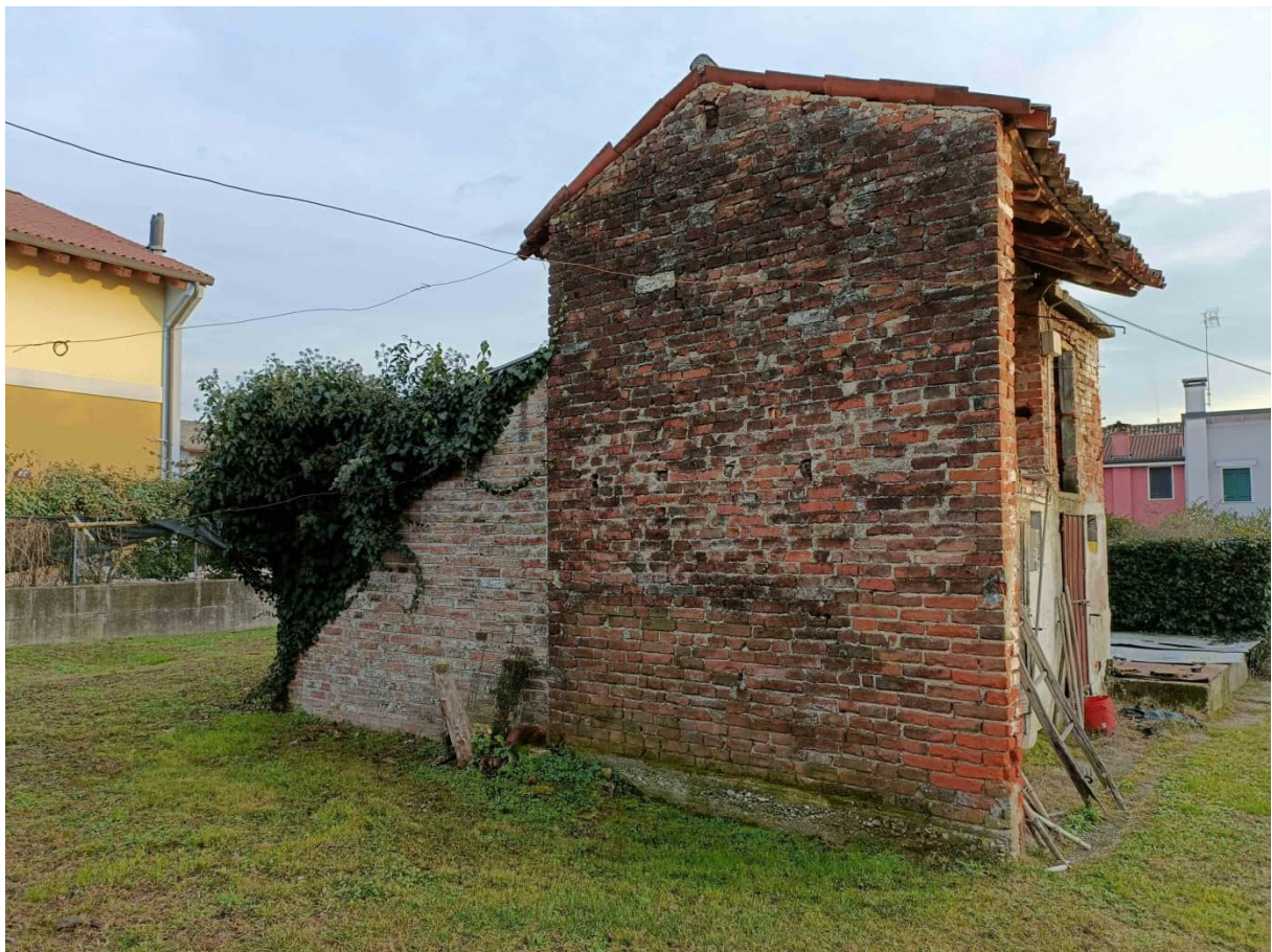
Foto 58: Fabbricato accessorio – Prospetto nord
