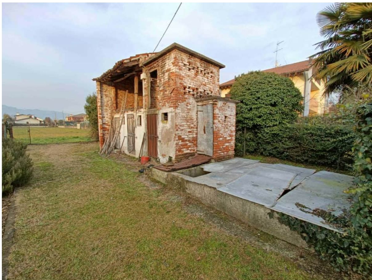
Foto 56: Fabbricato accessorio - Prospetti sud e ovest e concimaia
