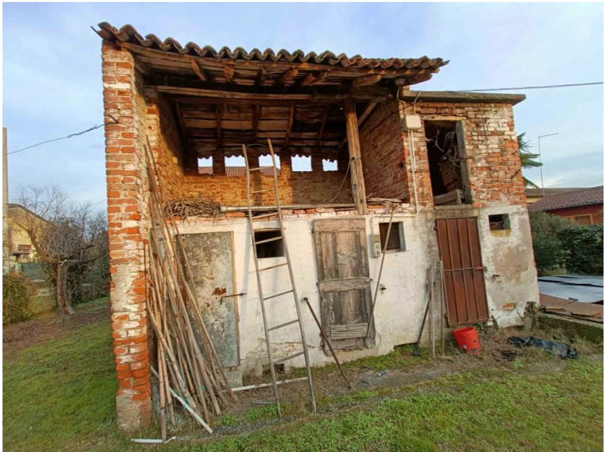
Foto 57: Fabbricato accessorio – Prospetto ovest
