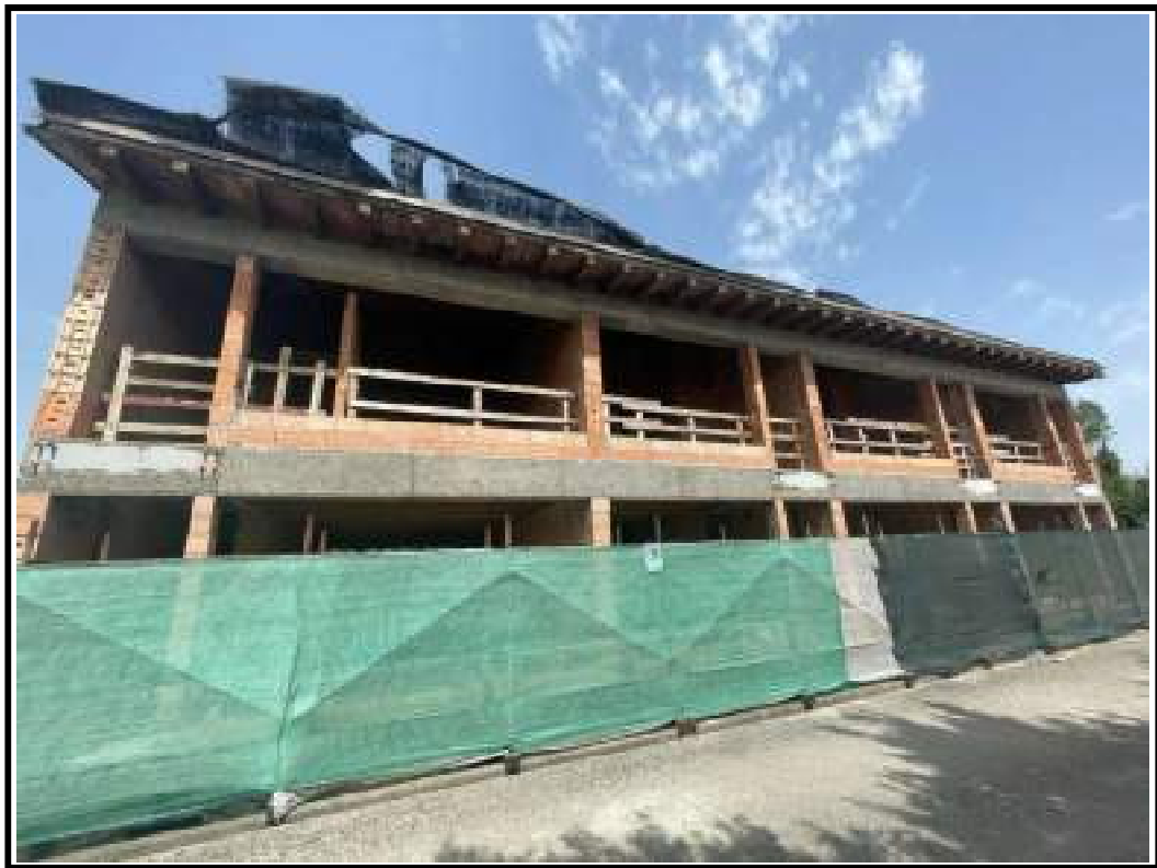
Foto 7 Fabbricato in corso di costruzione (Mapp. 126)
