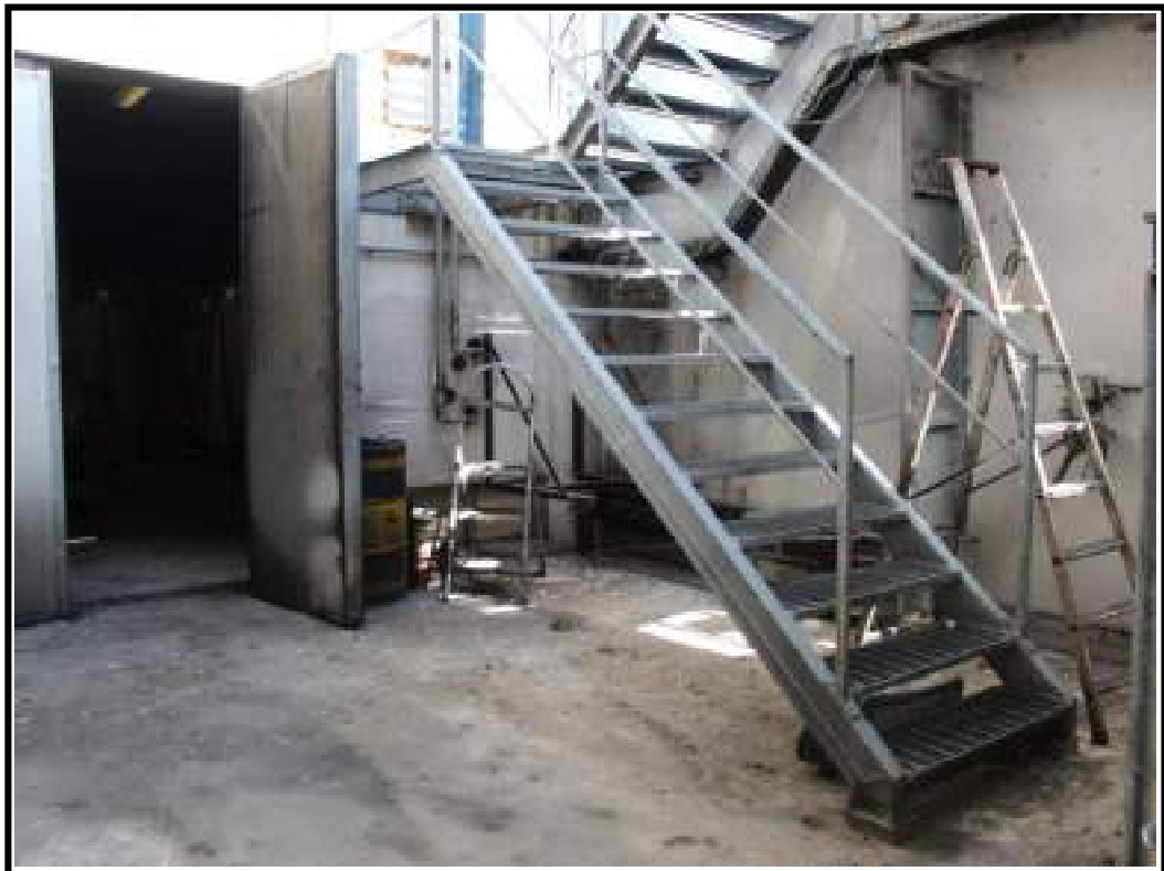
Foto 32 Scala di collegamento
