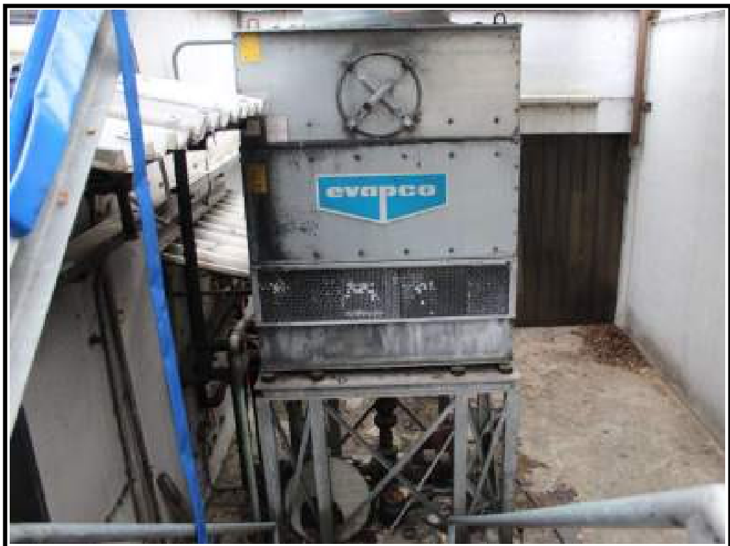
Foto 34 Accesso al locale di cogenerazione
