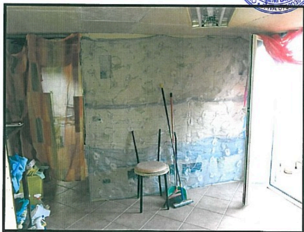
Figura 13 – Vista del magazzino
