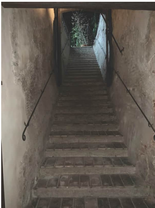
Vista della scala di accesso
