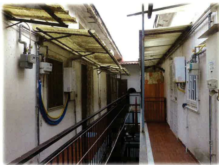
Foto 10 – Il ballatoio di distribuzione al secondo piano per le unità immobiliari site nella particella 74 e nella particella 76 – le unità pignorate sono sul lato destro l'accesso e dopo il cancelletto in fondo dietro la tenda arancio
