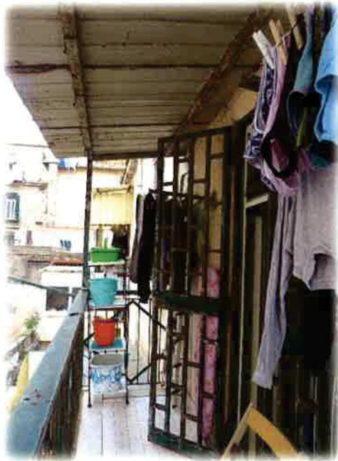
Foto 15 – Il balcone del sub 10
