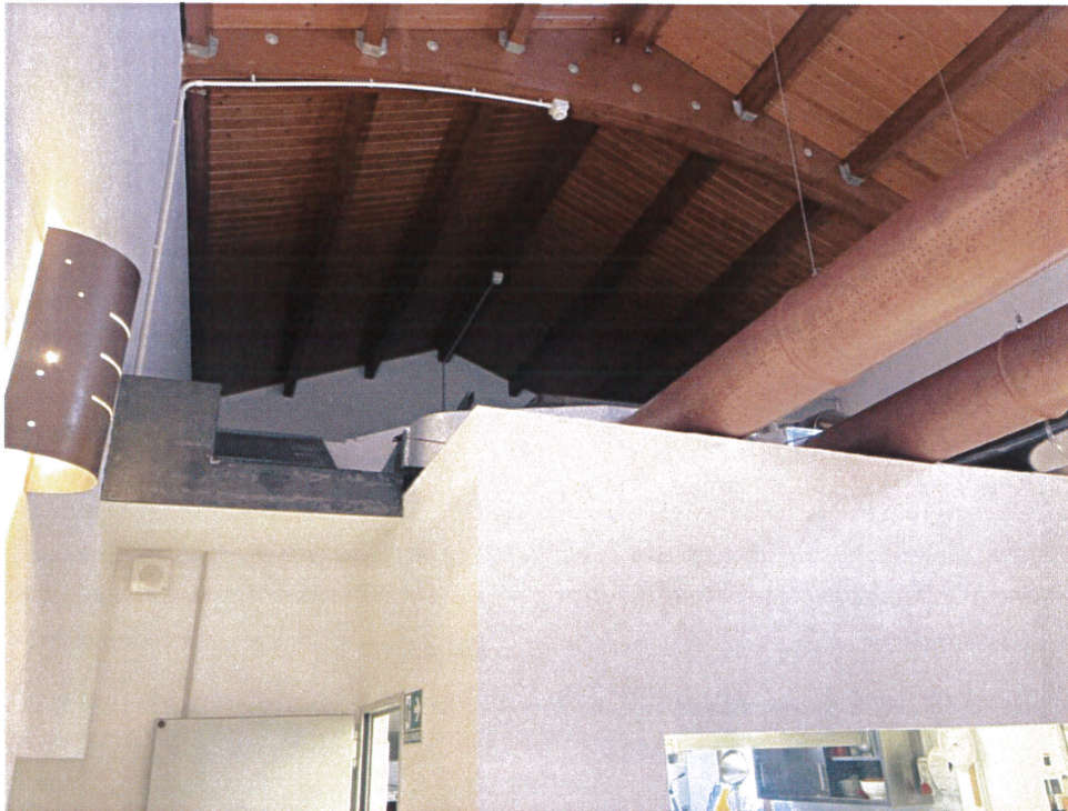
LOTTO N.2 – Fotografia n.9 – Piano Primo – Particolare della copertura lignea.
