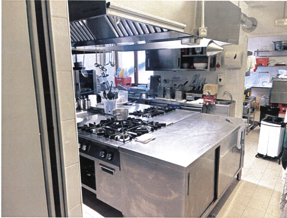
LOTTO N.2 – Fotografia n.8 – Piano Primo – L’Ambiente Cucina.
