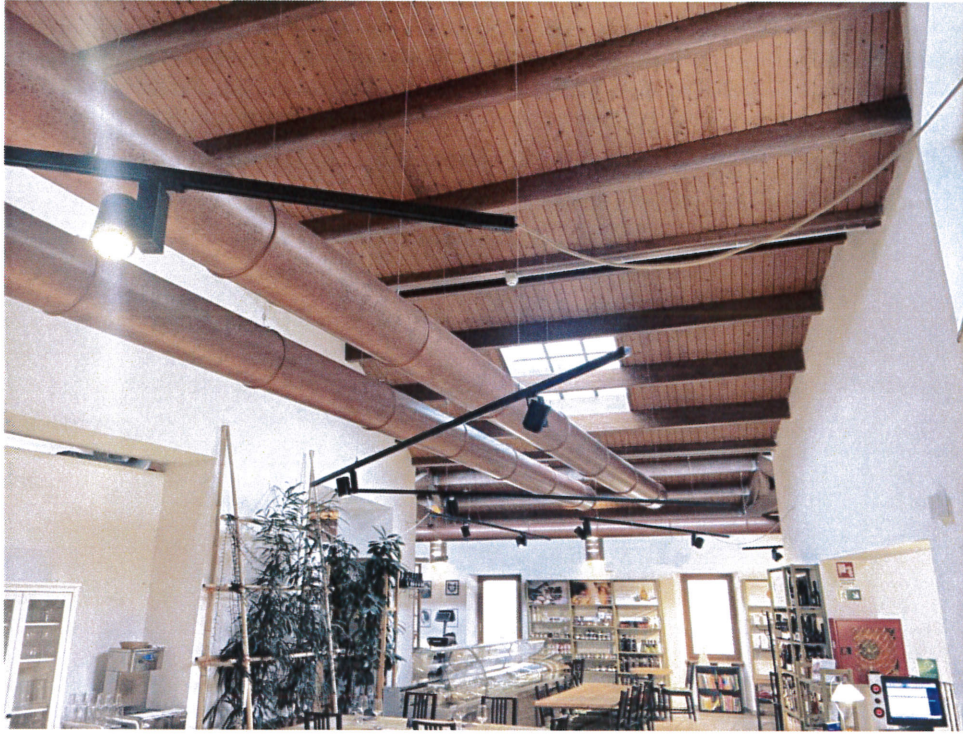
LOTTO N.2 – Fotografia n.10 – Piano Primo – Altra visuale della copertura lignea.
