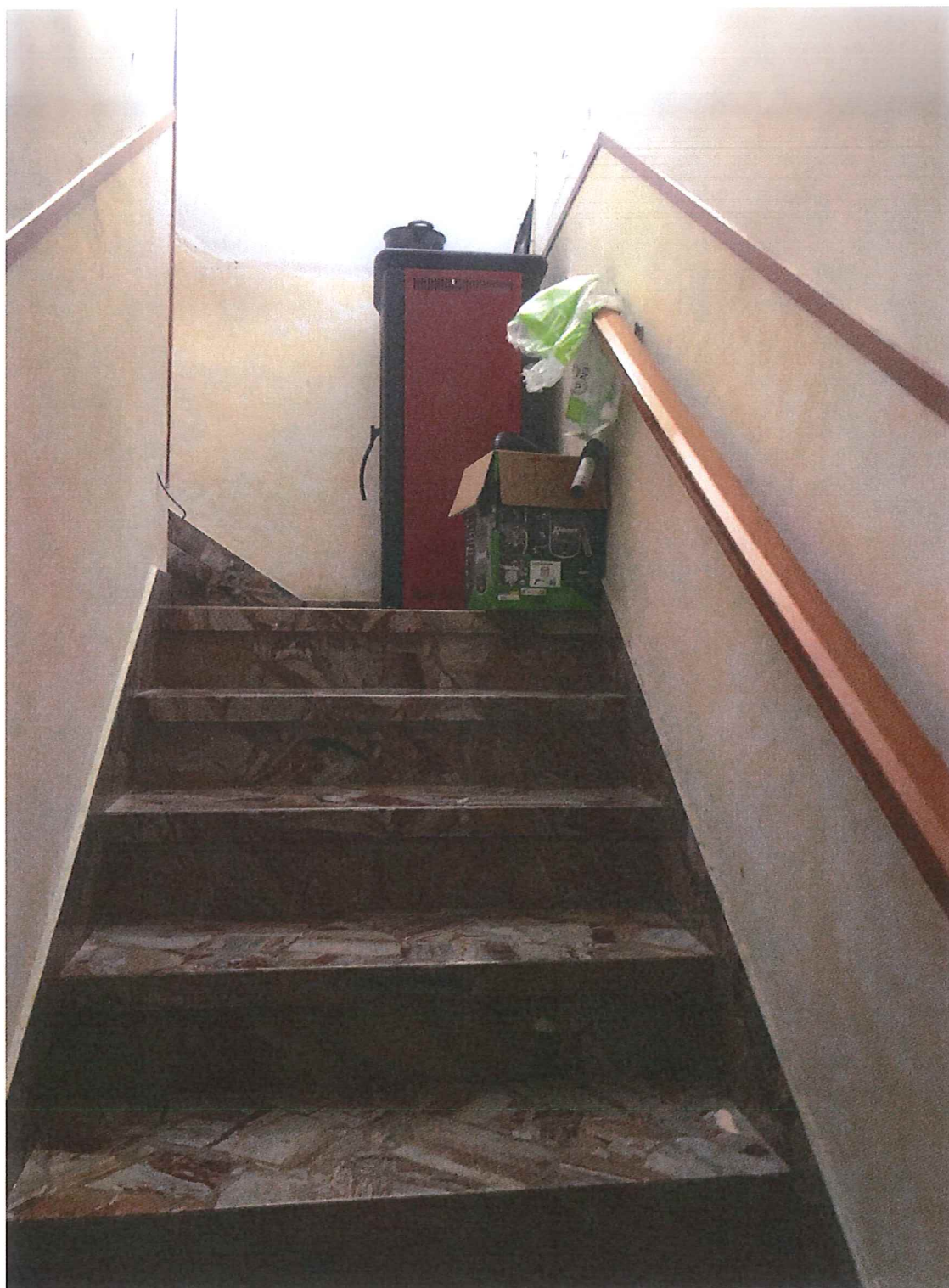
Foto n. 19 – Scala interna di collegamento al piano primo.
