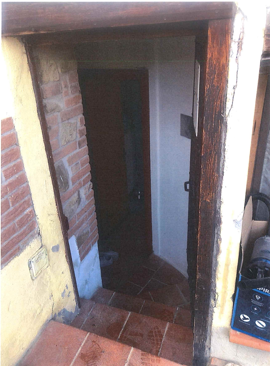
Foto n. 11 – Ingresso piano primo sottostrada.
