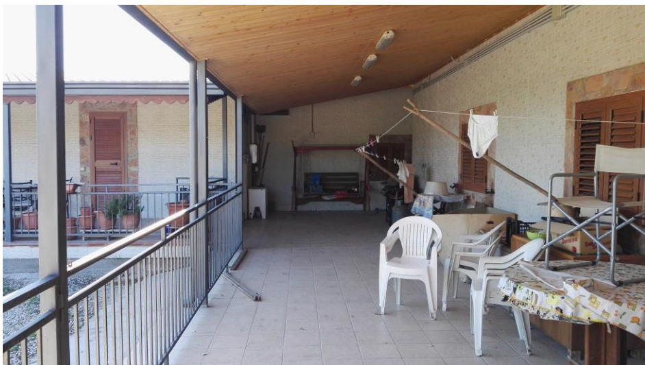
La veranda della p.la 126 che ricade sulla corte comune
