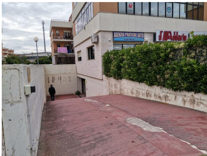
La rampa di accesso della p.lla 540 sub 62 foglio 76
