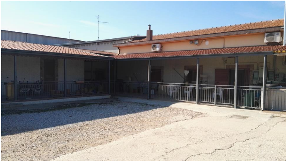
La corte con i fabbricati p.lle 126 e 128
