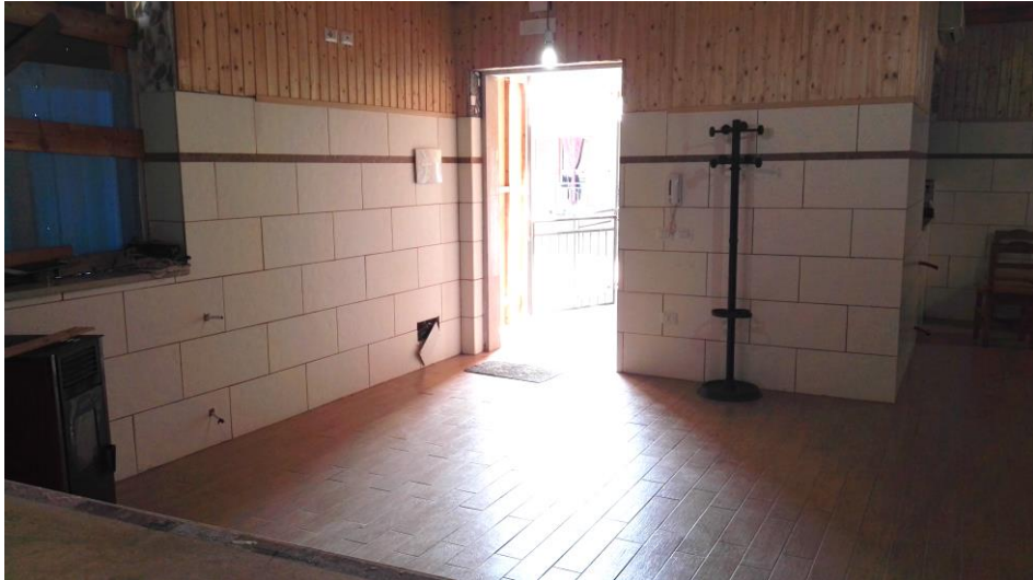
L'interno della p.lla 126 sub 1
