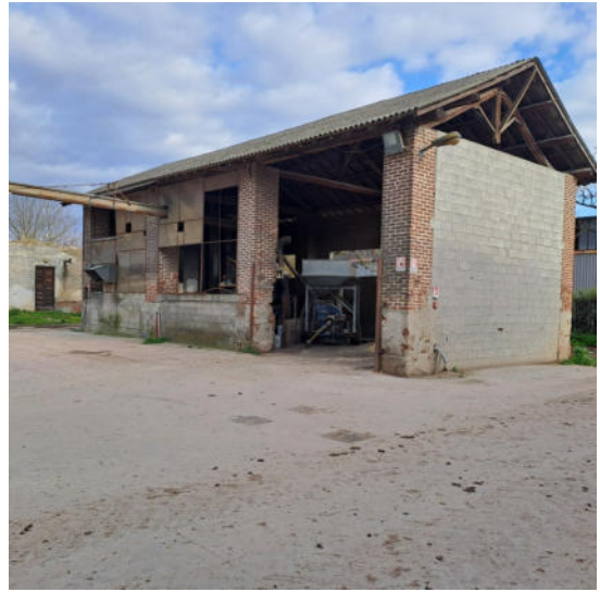
Foto 12 – Deposito essiccatoio n mt. 6,40.
