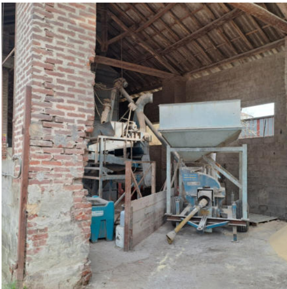
Foto 13 – Deposito essiccatoio n mt. 6,40.
