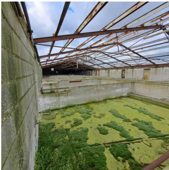
Foto 19 – Tettoia collabente - Interno.
