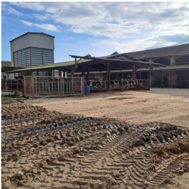
Foto 7 – Stalla h. mt. 3,60 e silos h mt. 10,80.
