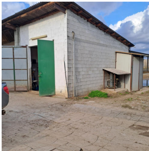
Foto 10 – Locale frigo h. mt. 4,05
