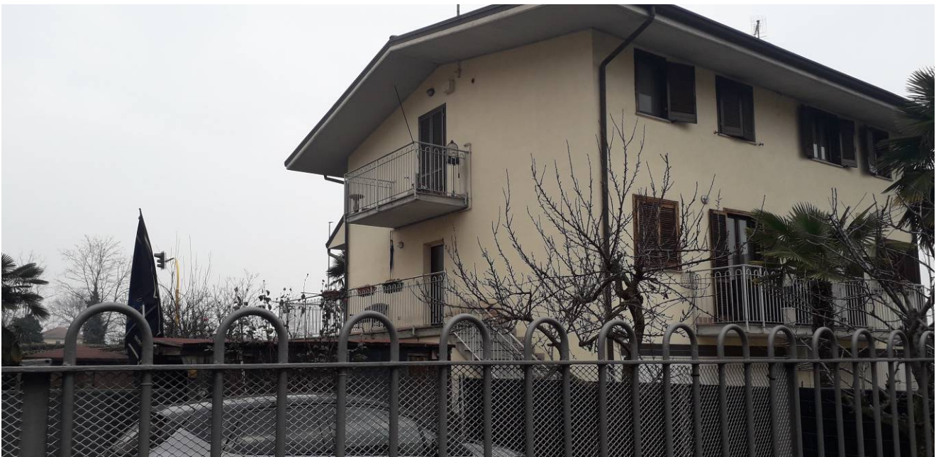
Prospetto Sud Ovest da Via Boccioni
