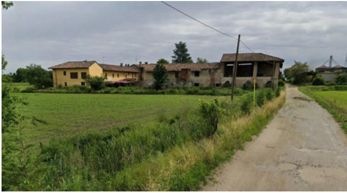
Foto 1 – Ingresso condominiale dalla Via Calabria
