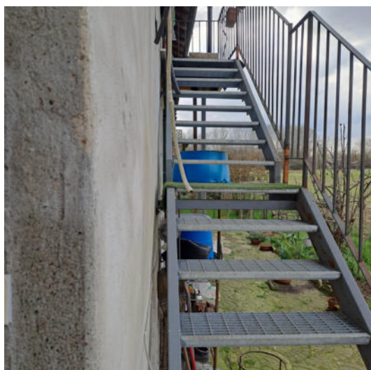
Foto 15 – Particolare della scala di collegamento al piano primo.
