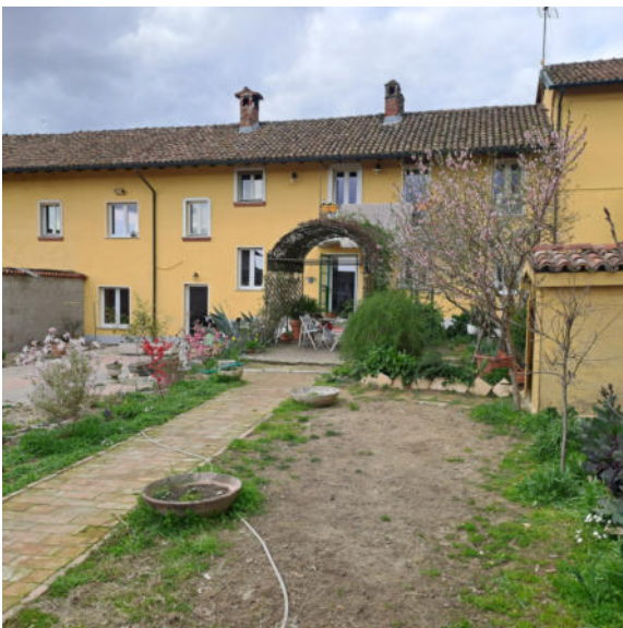
Foto 5 – Fabbricato residenziale – Lato ovest.
