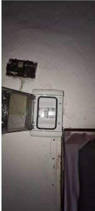
Nel quadro elettrico non sono presenti le indicazioni per l'identificazione delle linee alimentate dai vari dispositivi e non sono presenti le targhe identificative del quadro, come invece previsto dalla Norma CEI 23-51.
