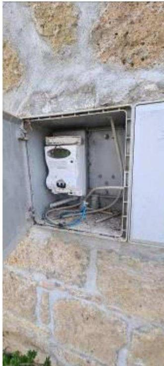
A tale dispositivo sono collegati conduttori che raggiungono, tramite corrugato sottotraccia, il quadro elettrico di distribuzione, posizionato all'interno del vano scala, realizzato con un centralino in resina a parete, con sportello, al cui interno è installato un interruttore differenziale da 25A con soglia di sensibilità di 0,03A.
