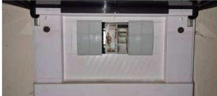
Nel quadro elettrico non sono presenti le indicazioni per l'identificazione delle linee alimentate dai vari dispositivi e non sono presenti le targhe identificative del quadro, come invece previsto dalla Norma CEI 23-51.
