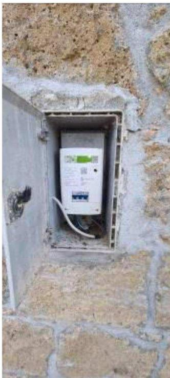
A tale dispositivo sono collegati conduttori che raggiungono, tramite corrugato sottotraccia, il quadro elettrico di distribuzione, posizionato all'interno dell'appartamento, realizzato con un centralino in resina, con sportello e fissato su contenitore incassato nella muratura, al cui interno è
