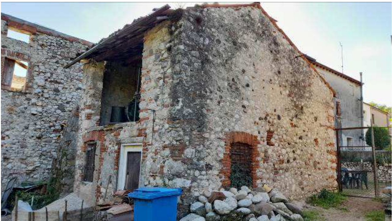
Figura 6. Vista nord-ovest, p.lla 1949.
