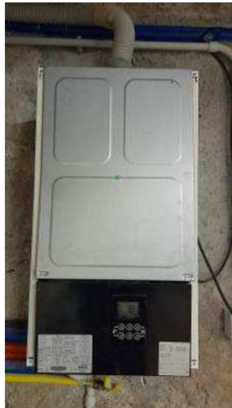
Figura 10. Caldaia in cantina.
