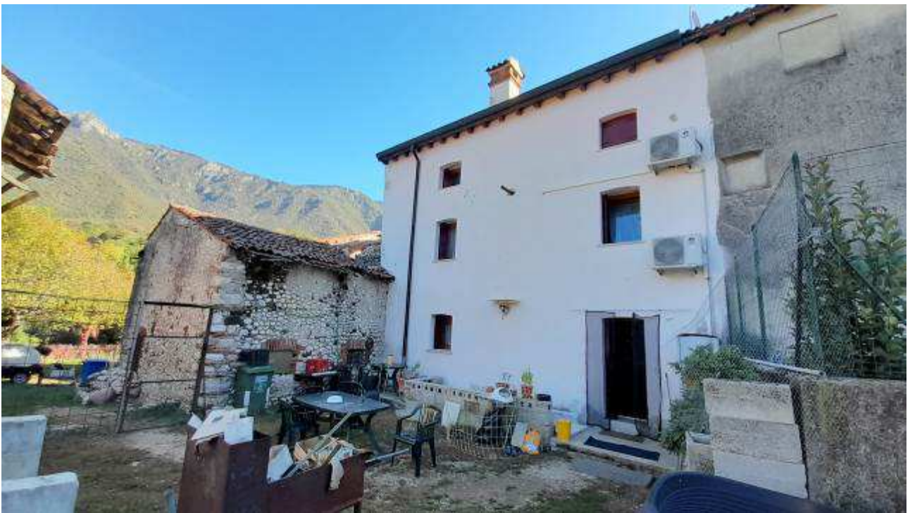
Figura 4. Vista sud-ovest, p.lle 507-1949.
