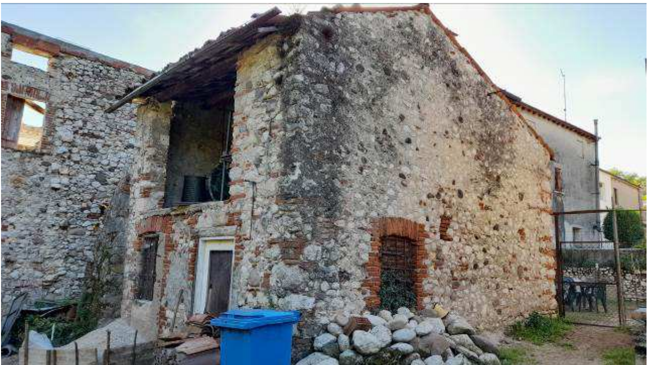
Figura 11. Vista nord-ovest, p.lla 1949.
