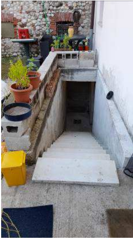
Figura 16. Scala non autorizzata di accesso alla cantina interrata.
