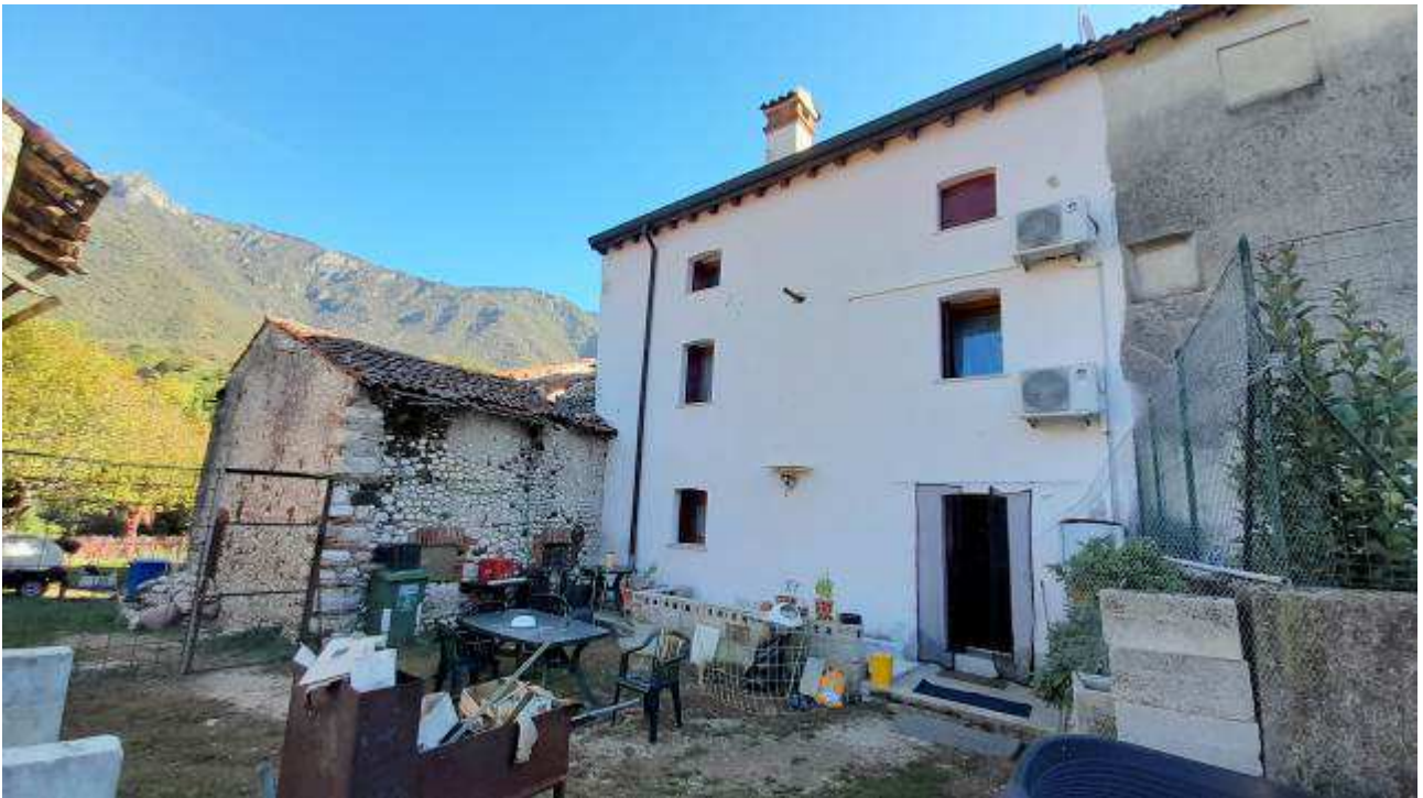
Figura 9. Vista sud-ovest, p.lle 507-1949.
