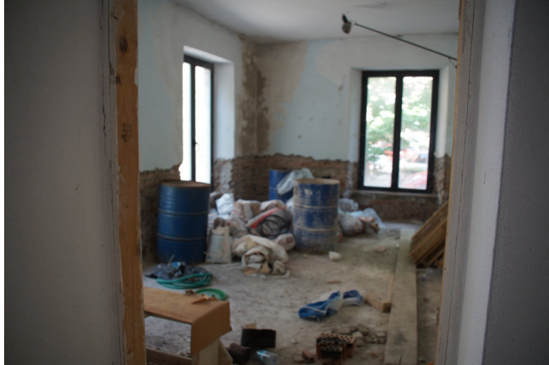
Foto n°25: particolare del locale ad uso ufficio posto nella parte sinistra della reception, si noti la presenza di finestre a battente doppio.
