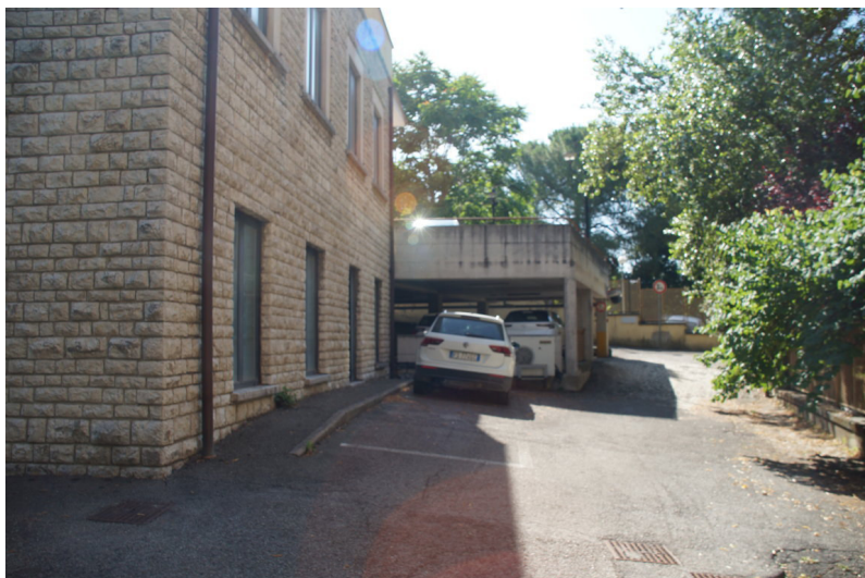
Foto n°5: altro particolare del piazzale condominiale carrabile posto lungo il lato Sud del fabbricato.
