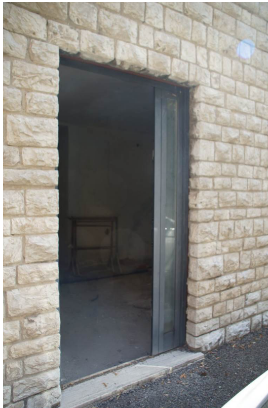
Foto n°23: particolare dell'ingresso posto lungo il lato SUD del fabbricato.
