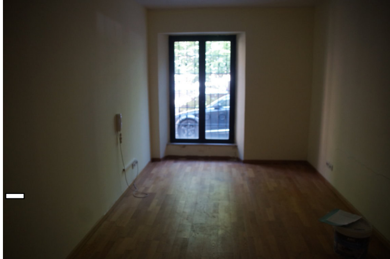
Foto n°21: particolare del secondo locale ad uso ufficio posto in adiacenza alla zona di attesa.
