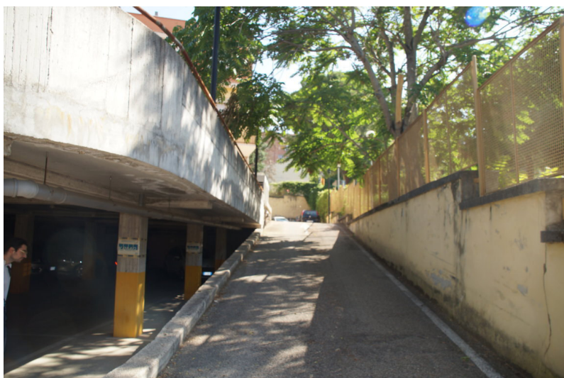
Foto n°6: altro particolare dell'accesso carrabile che corre lungo il lato Est del fabbricato, si noti la presenza della zona di parcheggio coperta al piano primo sottostrada.
