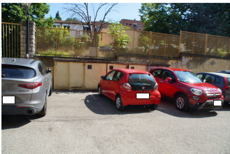
Foto n°8: particolare dell'alloggiamento contatori di acqua, luce e gas posti nella parte del piazzale condominiale a Nord del fabbricato.
