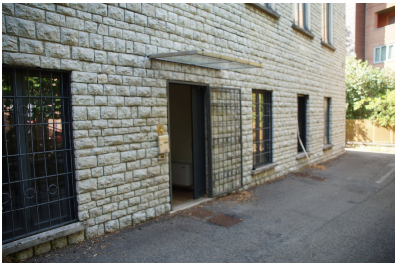
Foto n°4: particolare dell'accesso carrabile condominiale posto lungo il lato Ovest dell'immobile.
