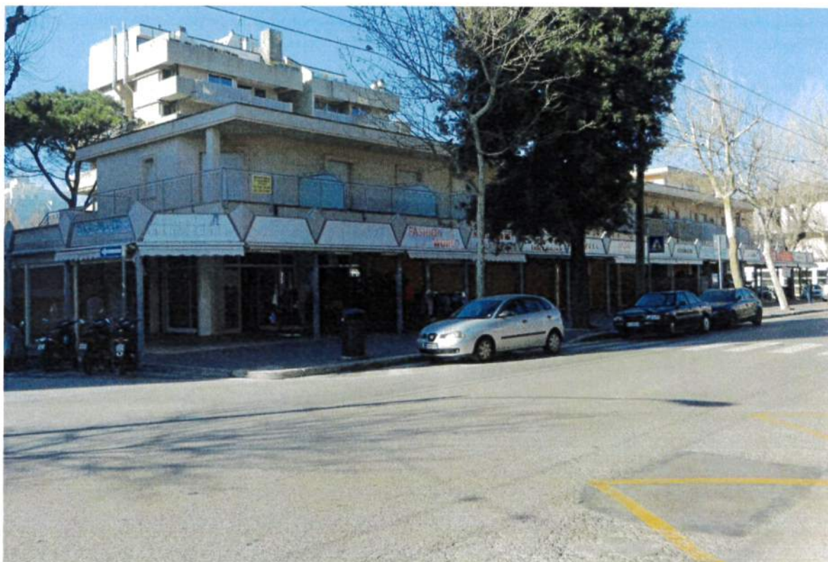
fronte intero complesso edilizio
