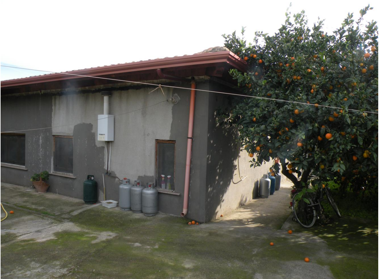
Foto n° 4 – Immobile censito nel N.C.E.U. al fg 25 par.la 115 – Angolo Nord-Ovest
