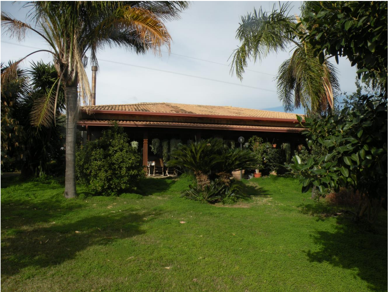
Foto n° 1 – Immobile censito nel N.C.E.U. al fg 25 par.la 115 – Prospetto Sud
