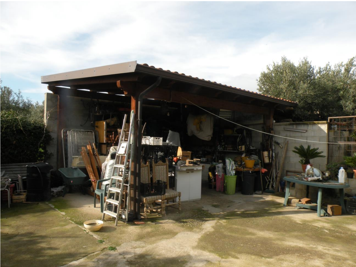
Foto n° 16 – Tettoia realizzata sul terreno censito nel N.C.T. al fg 25 par.Ila125
