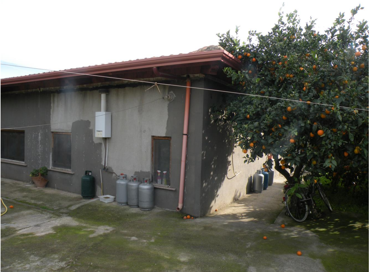
Foto n° 4 – Immobile censito nel N.C.E.U. al fg 25 par.lla 115 – Angolo Nord-Ovest
