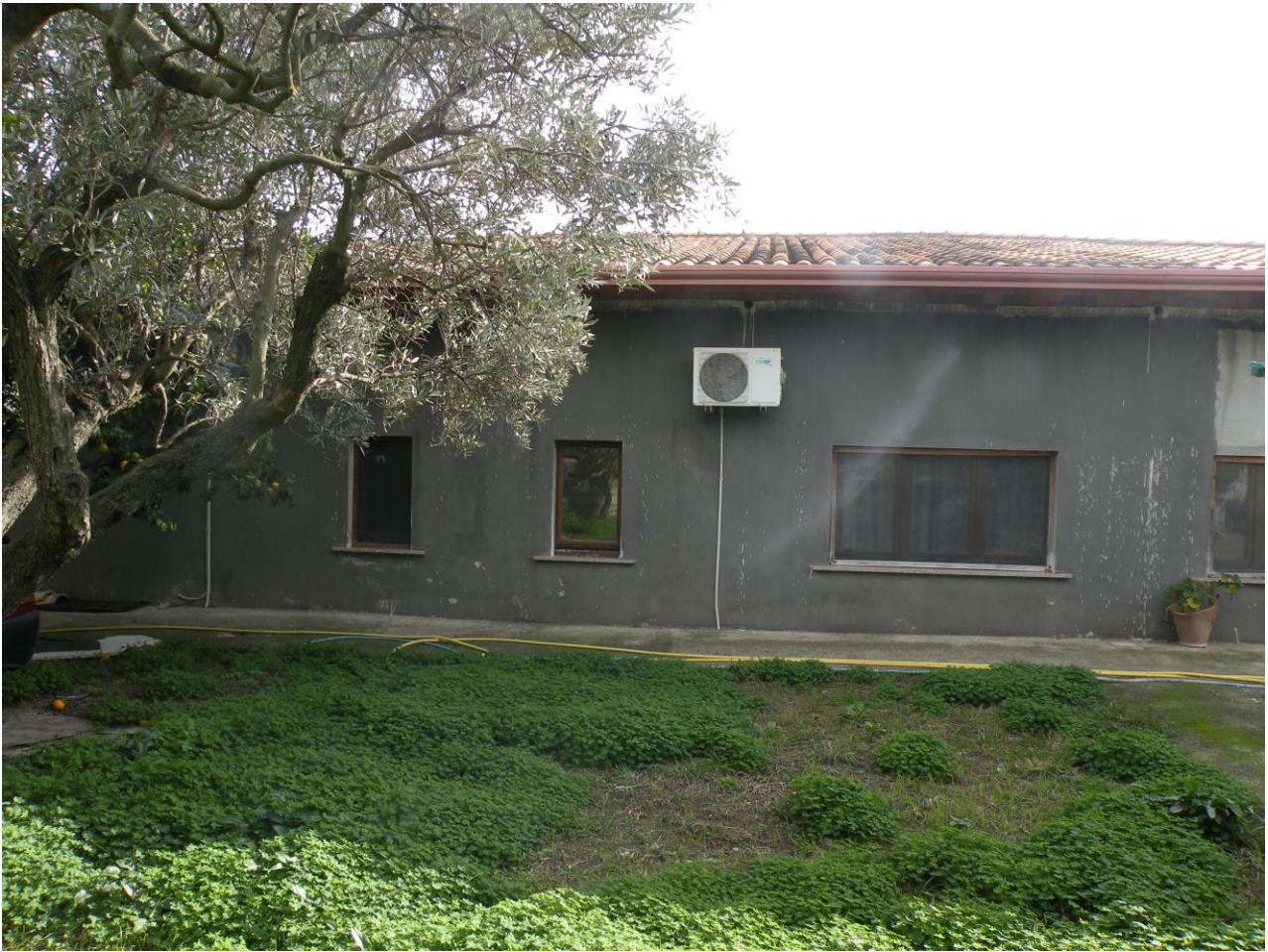
Foto n° 3 – Immobile censito nel N.C.E.U. al fg 25 par.lla 115 – Prospetto Nord
