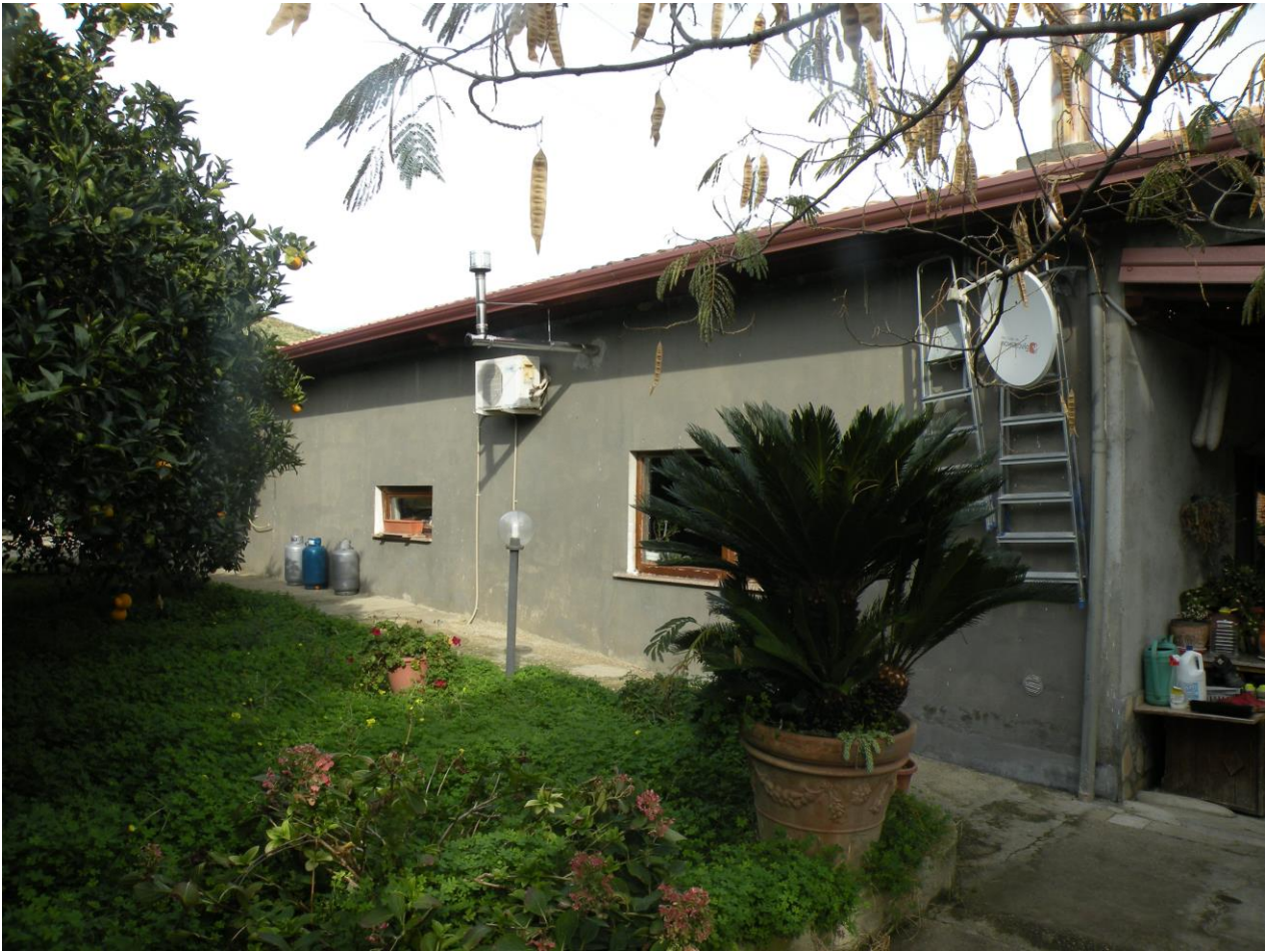
Foto n° 5 – Immobile censito nel N.C.E.U. al fg 25 par.la 115 – Prospetto Ovest
