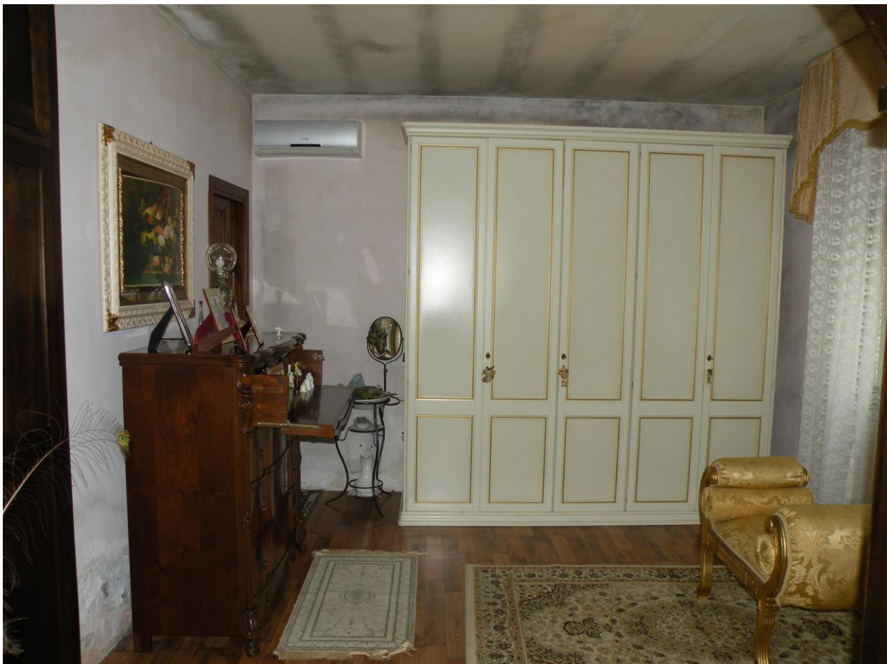
Foto n° 12 – Immobile censito nel N.C.E.U. al fg 25 par.la 115 – Camera 3
