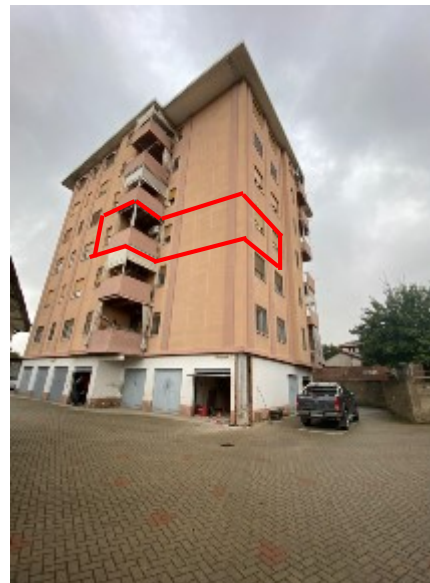
Facciata su cortile interno ribassato
