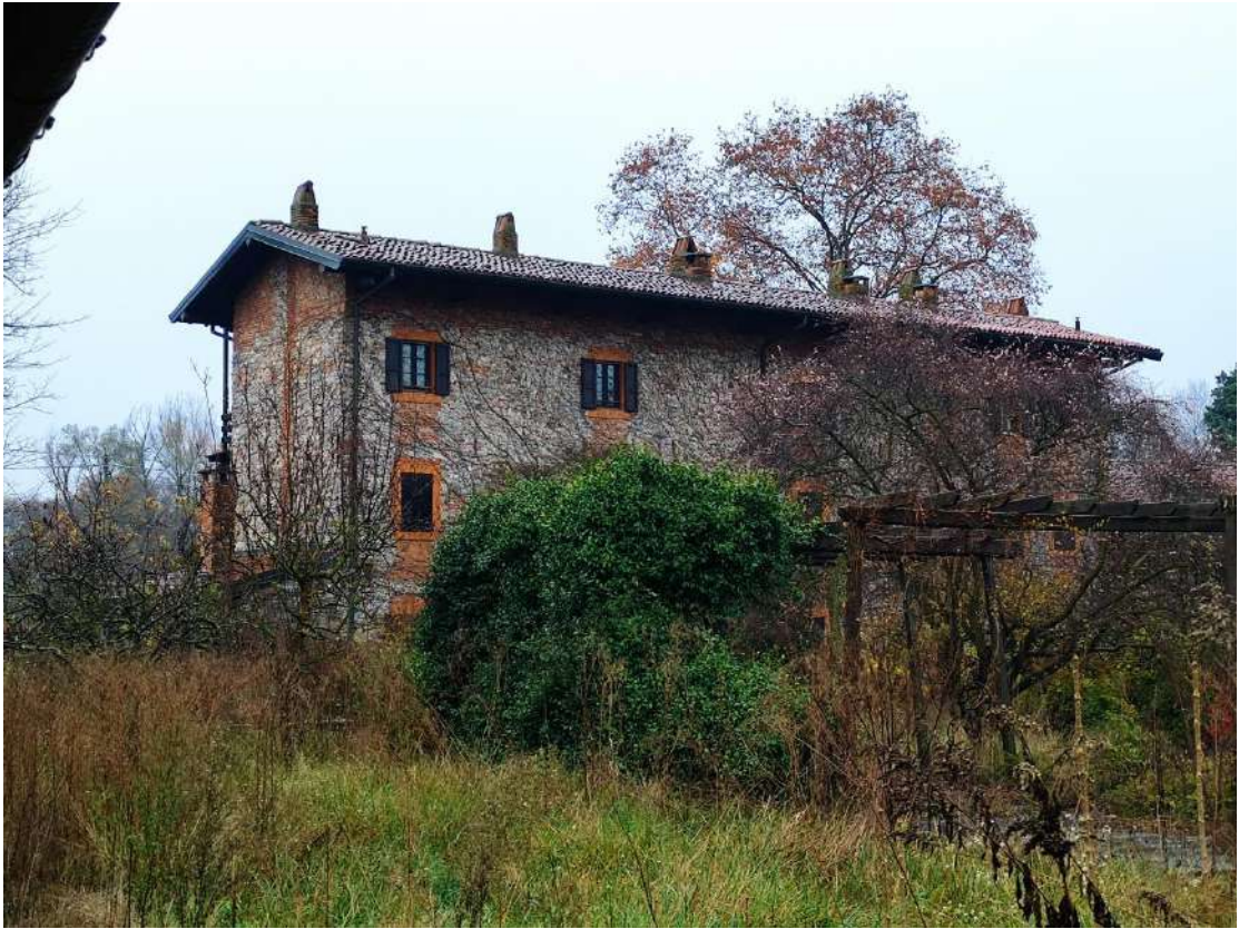
Vista esterno fabbricato
