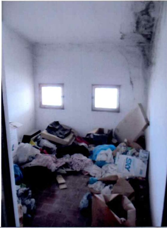
9 – Particolare d'interni: Soffitta
