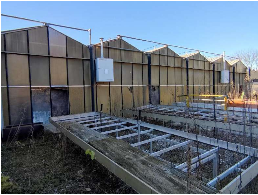
Vista esterno fabbricato
