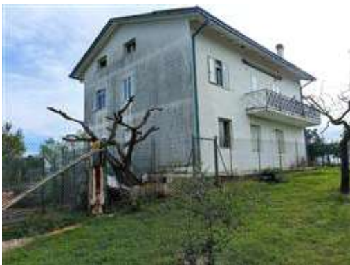
L'edificio visto dallo scoperto, con doppie finestre di tipo economico
