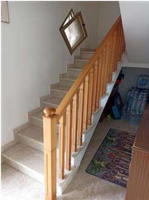
Il vano scala che serve i tre livelli fuori terra, con finiture semplici
