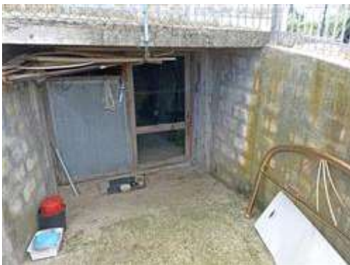
La rampa verso il piano SI, internamente allo stato grezzo
