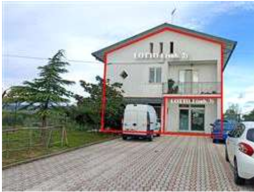
L'edificio visto dall'accesso comune (è presente anche un piano interrato)
