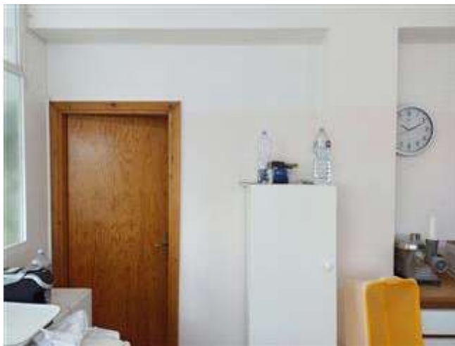
La porta (difforme) tra abitazione (sub. 2) e laboratorio (sub. 3)
