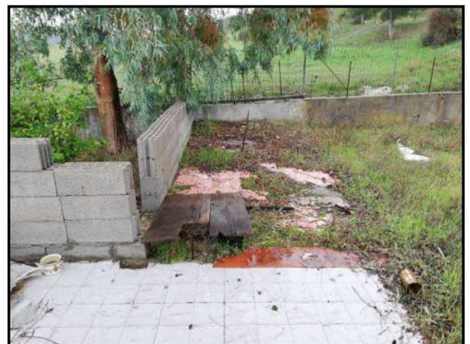
Foto 9 - Area servizi igienici demoliti
