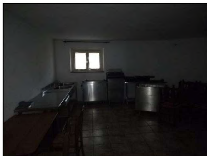
Foto 13 - Magazzino 2 piano terra - seminterrato
