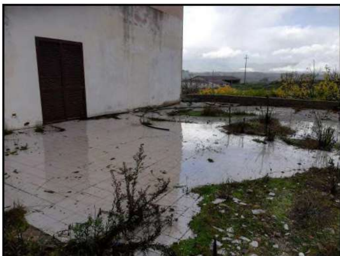
Foto 8 - Pavimentazione sala in ampliamento demolita
