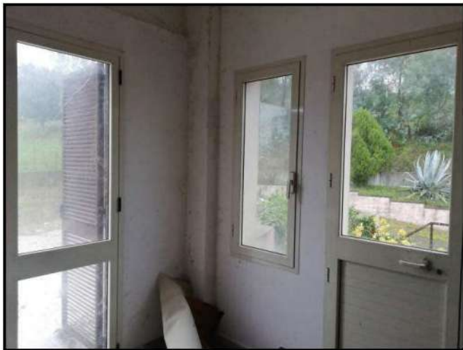
Foto 6 - Passaggio coperto ingresso lato sud
