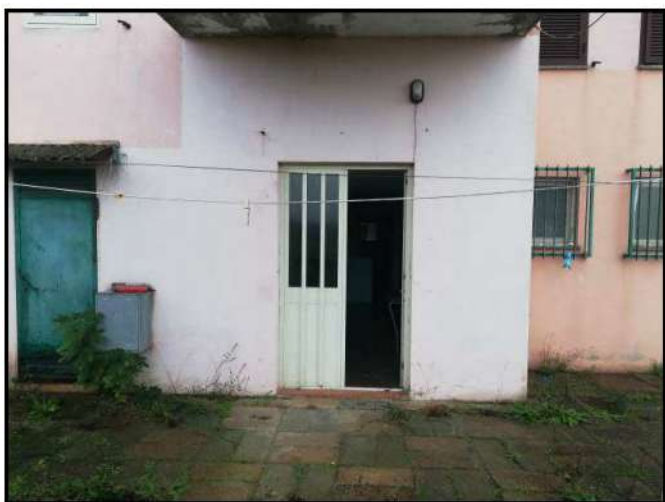
Foto 18 - Ingresso lato nord piano terra - seminterrato
