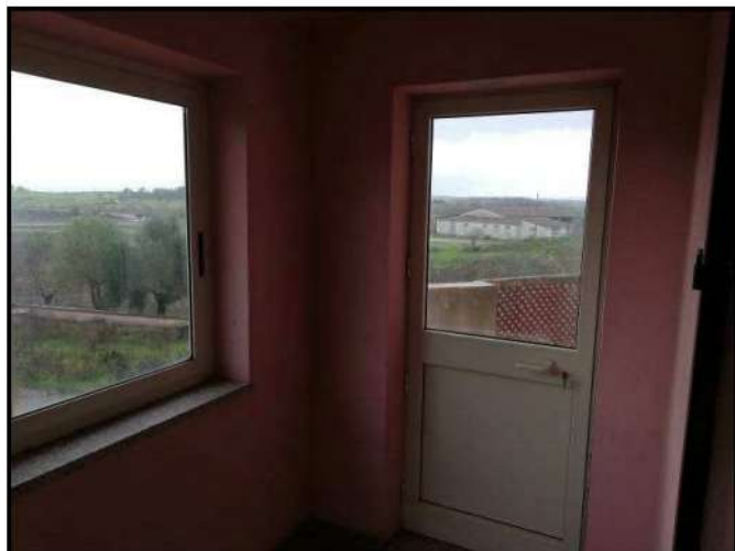
Foto 3 - Interno veranda 1 ingresso principale
