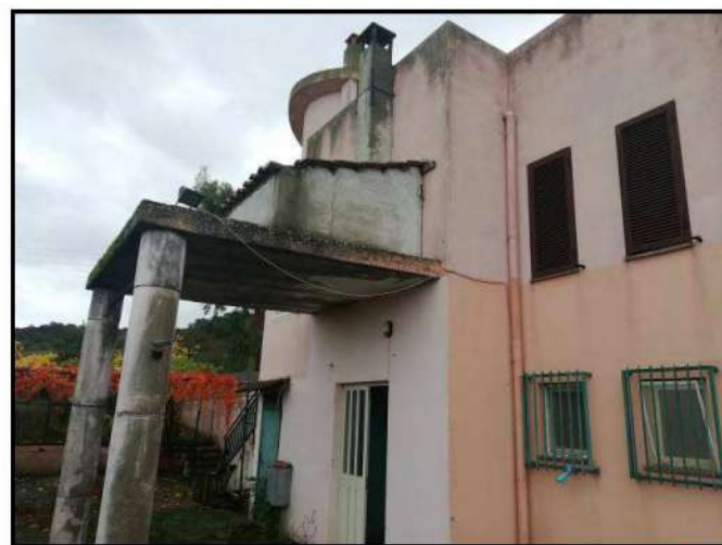
Foto 19 - Ingresso lato nord piano terra - seminterrato
