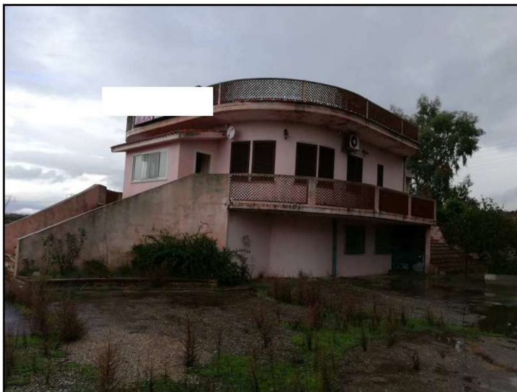
Foto 2 - Prospetto laterale sud
