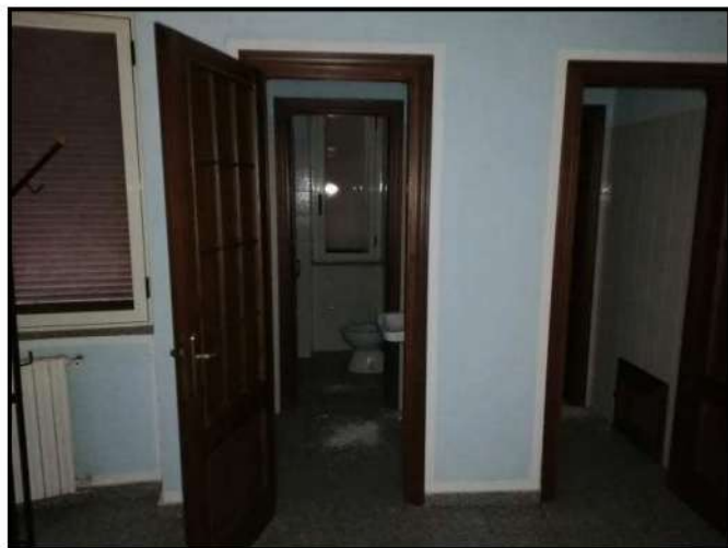
Foto 21 - Bagni sala ristorante
