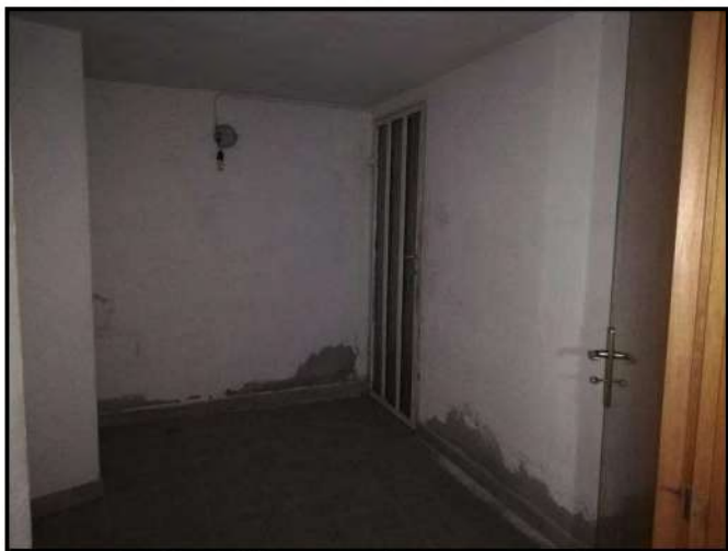
Foto 16 - Disimpegno piano terra - seminterrato
