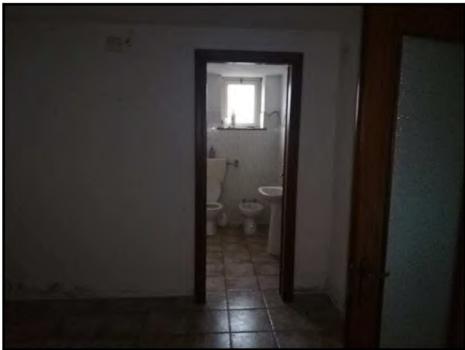
Foto 14 - Bagni per il personale piano terra - seminterrato
