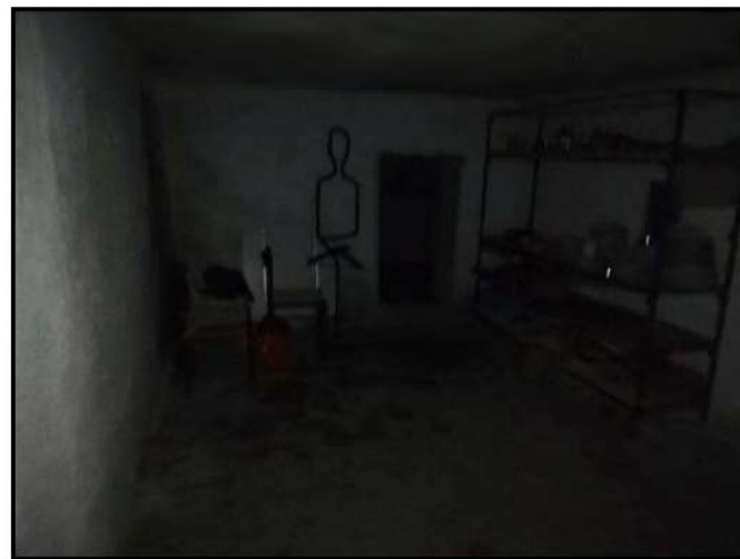
Foto 17 - Cantina piano terra - seminterrato
