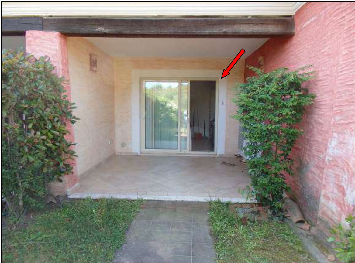
Foto n° 3 – Veranda - (freccia: ingresso).
