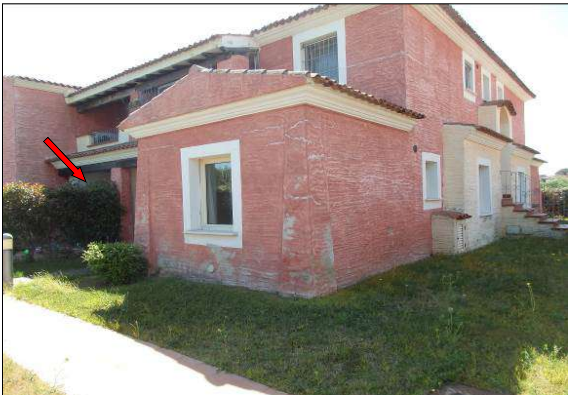
Foto n° 2 - Vista esterna dal giardino - (Freccia: veranda esterna di accesso).
