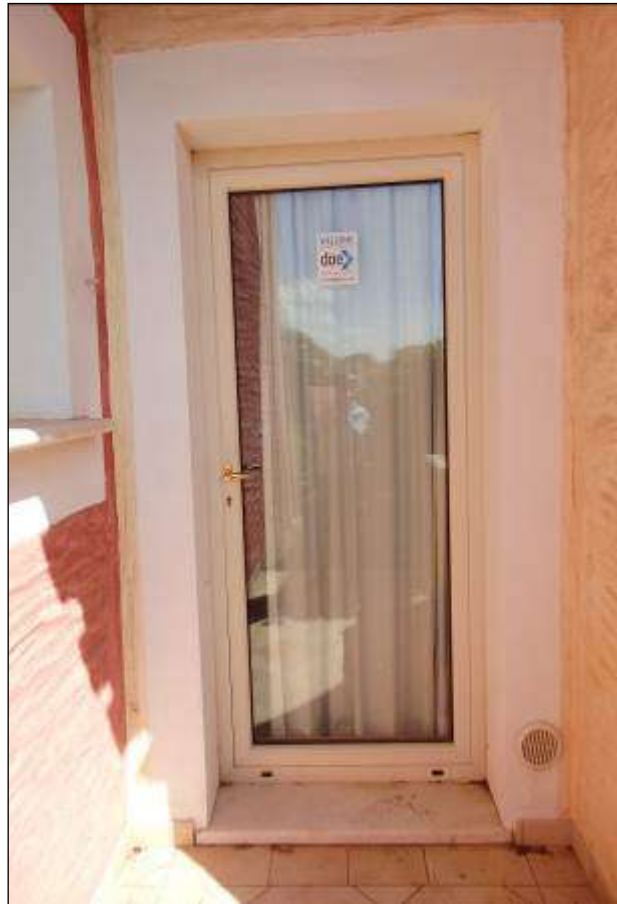
Foto n° 35 – Tipologia infisso esterno (portafinestra).
