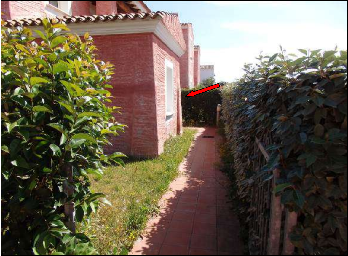
Foto n° 13 – Foto n° 13 – Vista esterna dal giardino - (Freccia: veranda esterna di accesso).
