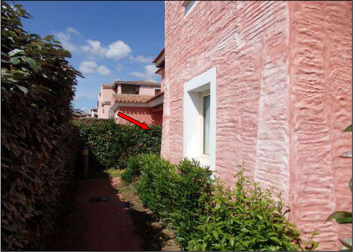
Foto n° 13 – Foto n° 23 – Vista esterna dal giardino - (Freccia: veranda esterna di accesso).
