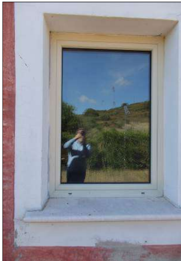
Foto n° 36 – Tipologia infisso esterno (finestra).
