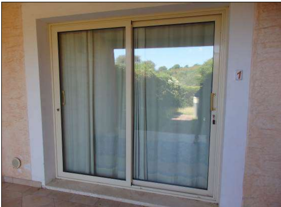
Foto n° 34 – Tipologia scorrevole esterno.
