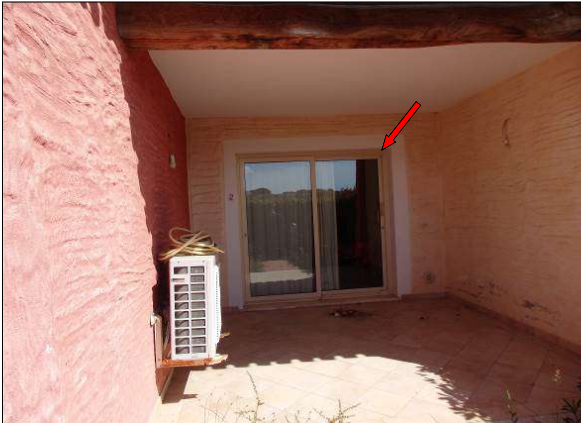
Foto n° 14 – Veranda - (freccia: ingresso).
