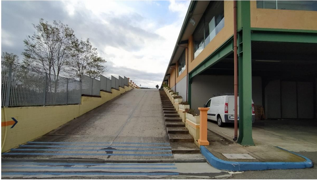
Foto 7: rampa di collegamento tra la corte ed il piazzale presente a livello del primo piano.
