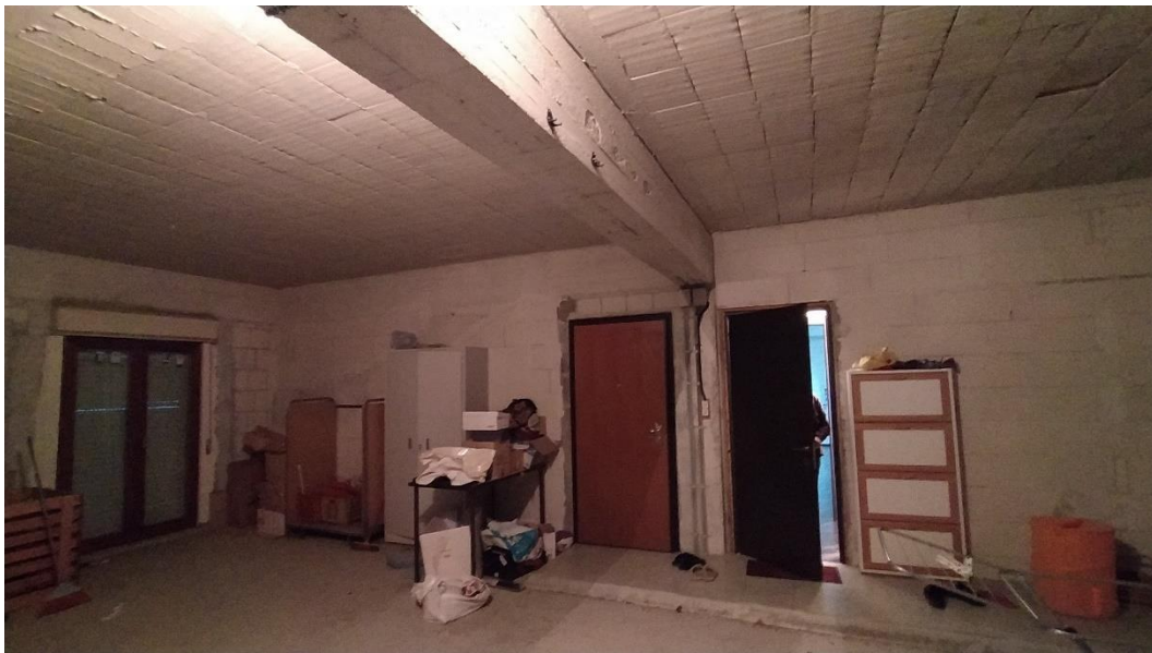
Foto 4: Catasto Fabbricati di Sant'Eufemia d'A., foglio 3, particella 475 sub 5, Corso Umberto I. Appartamento in corso di costruzione. Sulla sinistra, porta d'accesso dal vano scala; sulla destra, porta che al momento mette in comunicazione il sub 5 con il sub 4.
