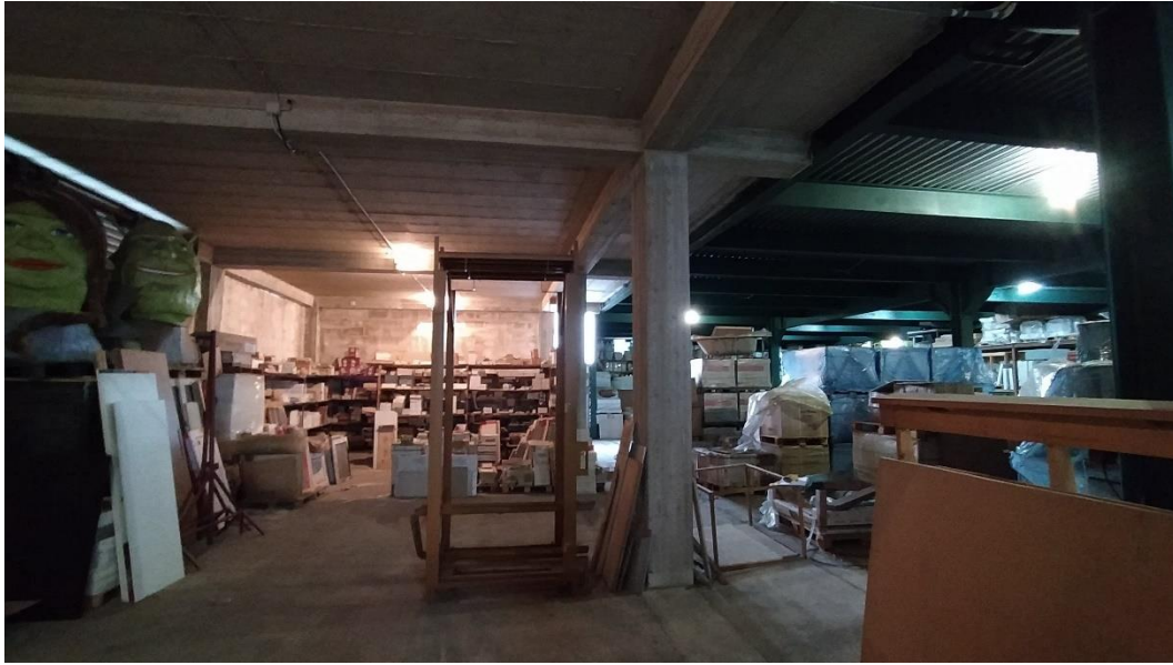
Foto 5: interno del deposito al piano terra, realizzato al di sotto del piazzale di accesso al primo piano.
