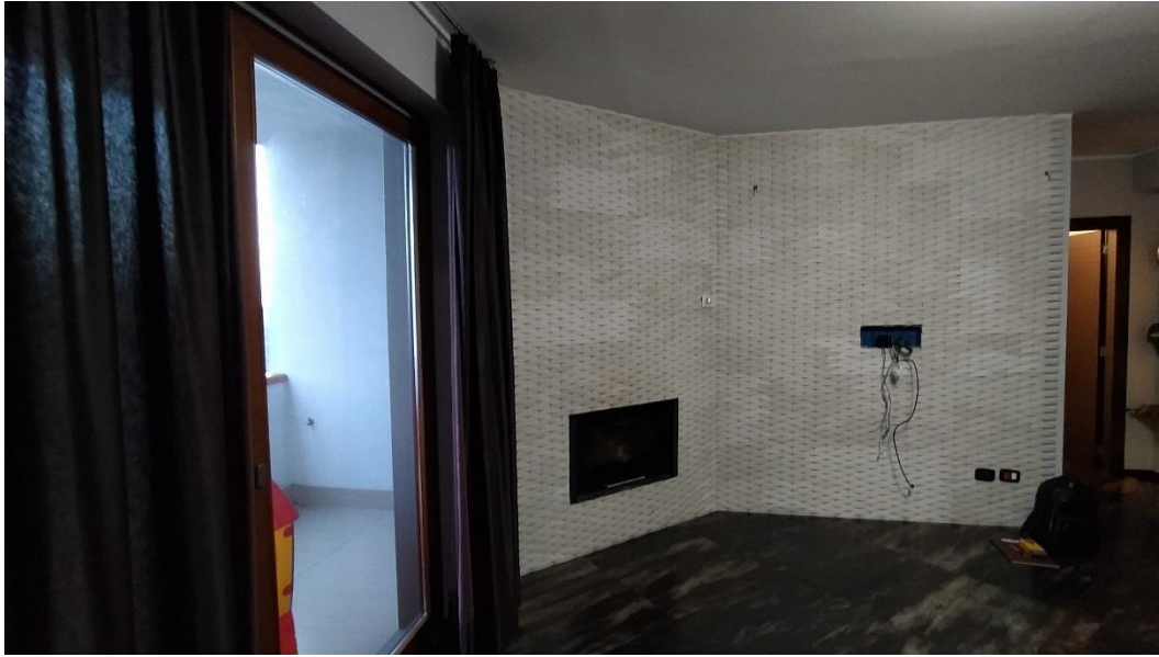
Foto 3: Catasto Fabbricati di Sant'Eufemia d'A., foglio 3, particella 475 sub 4, Corso Umberto I. Soggiorno.
