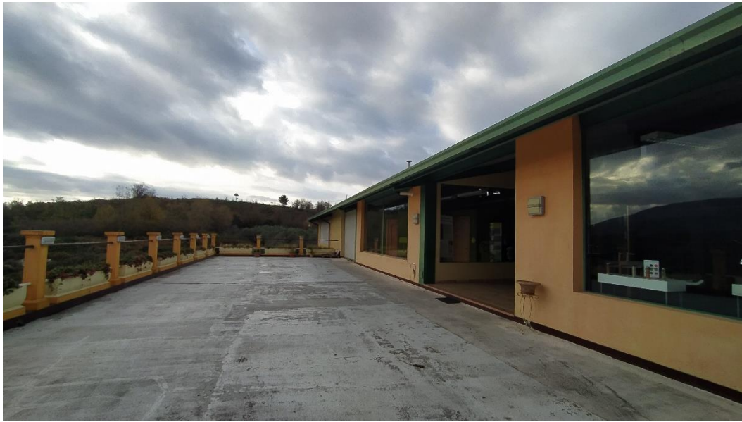
Foto 8: piazzale realizzato al livello del primo piano.
