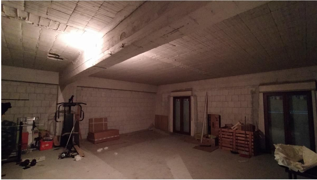
Foto 3: Catasto Fabbricati di Sant'Eufemia d'A., foglio 3, particella 475 sub 5, Corso Umberto I. Appartamento in corso di costruzione.
