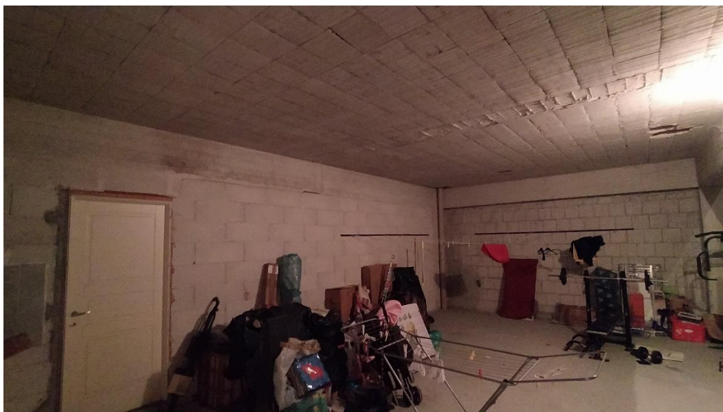
Foto 2: Catasto Fabbricati di Sant'Eufemia d'A., foglio 3, particella 475 sub 5, Corso Umberto I. Appartamento in corso di costruzione.
