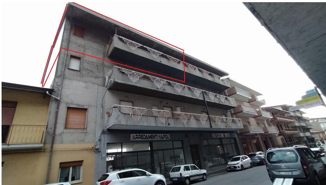
Foto 1: Catasto Fabbricati di Sant'Eufemia d'A., foglio 3, particella 475 sub 11, Corso Umberto I. Appartamento al terzo piano (4° f.t.).
