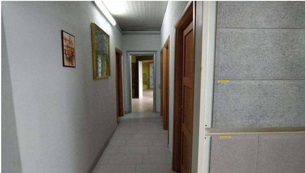
Foto 12: area uffici e servizi igienici, al primo piano.
