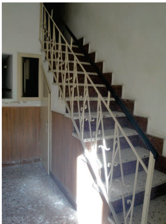
foto 3_ veduta interna della scala di accesso ai piani superiori
