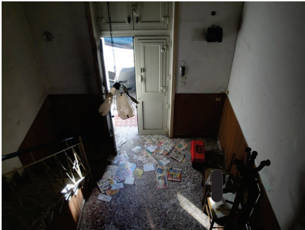
foto 2_ veduta interna della zona di ingresso
