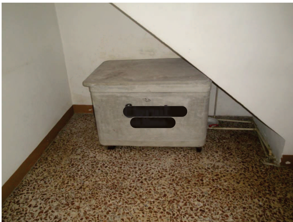
foto 7_ serbatoio in amianto-eternit nel piano soppalcato
