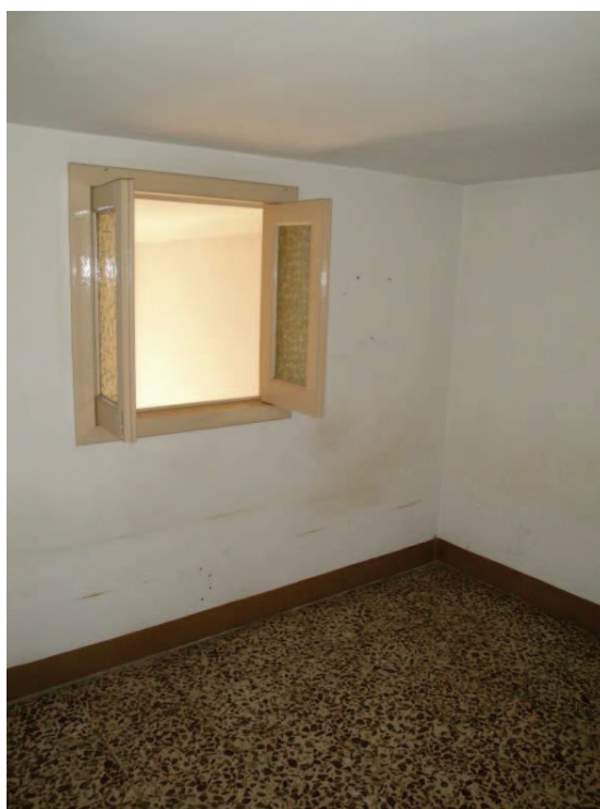
foto 6_ veduta interna della zona soppalco
