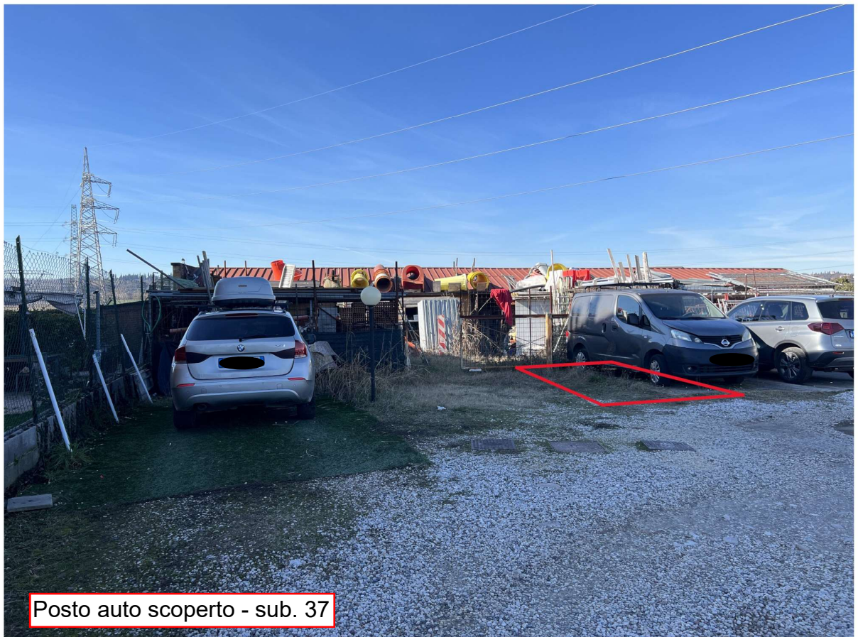
Esterno deposito - sub. 52
