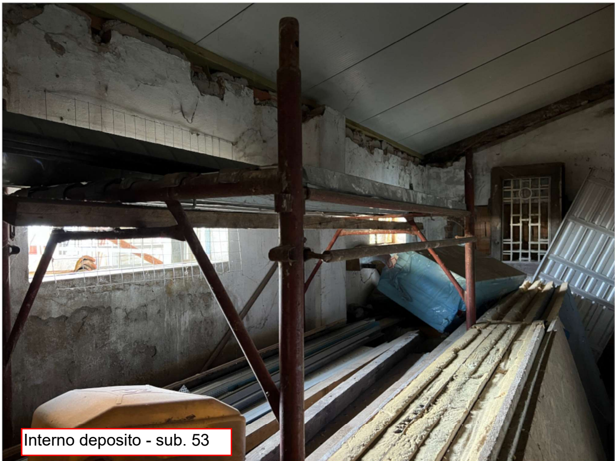
Interno deposito - sub. 53
