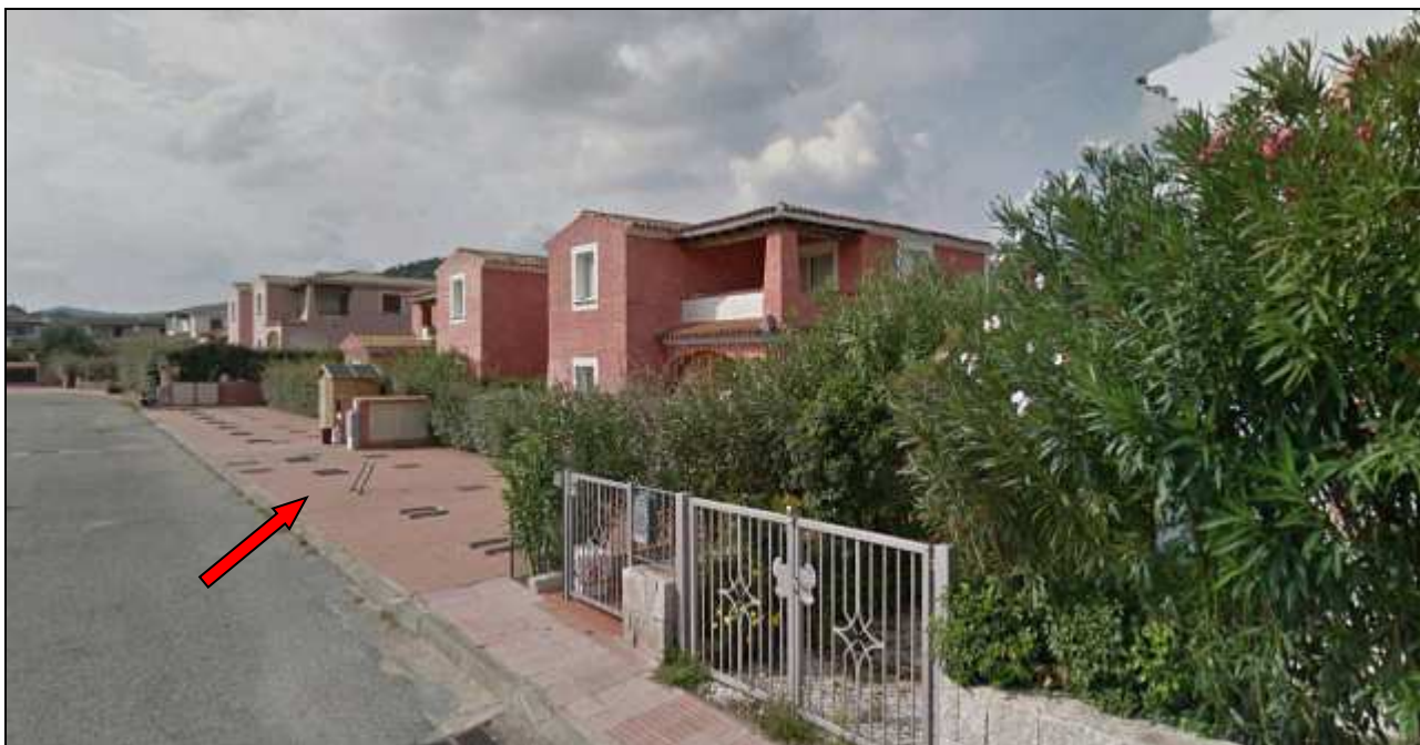
Foto n° 1 – Posti auto su Via Delle Querce (Foglio 237 - Part. 508, Sub. 13-15-16-17-18-19-20).
