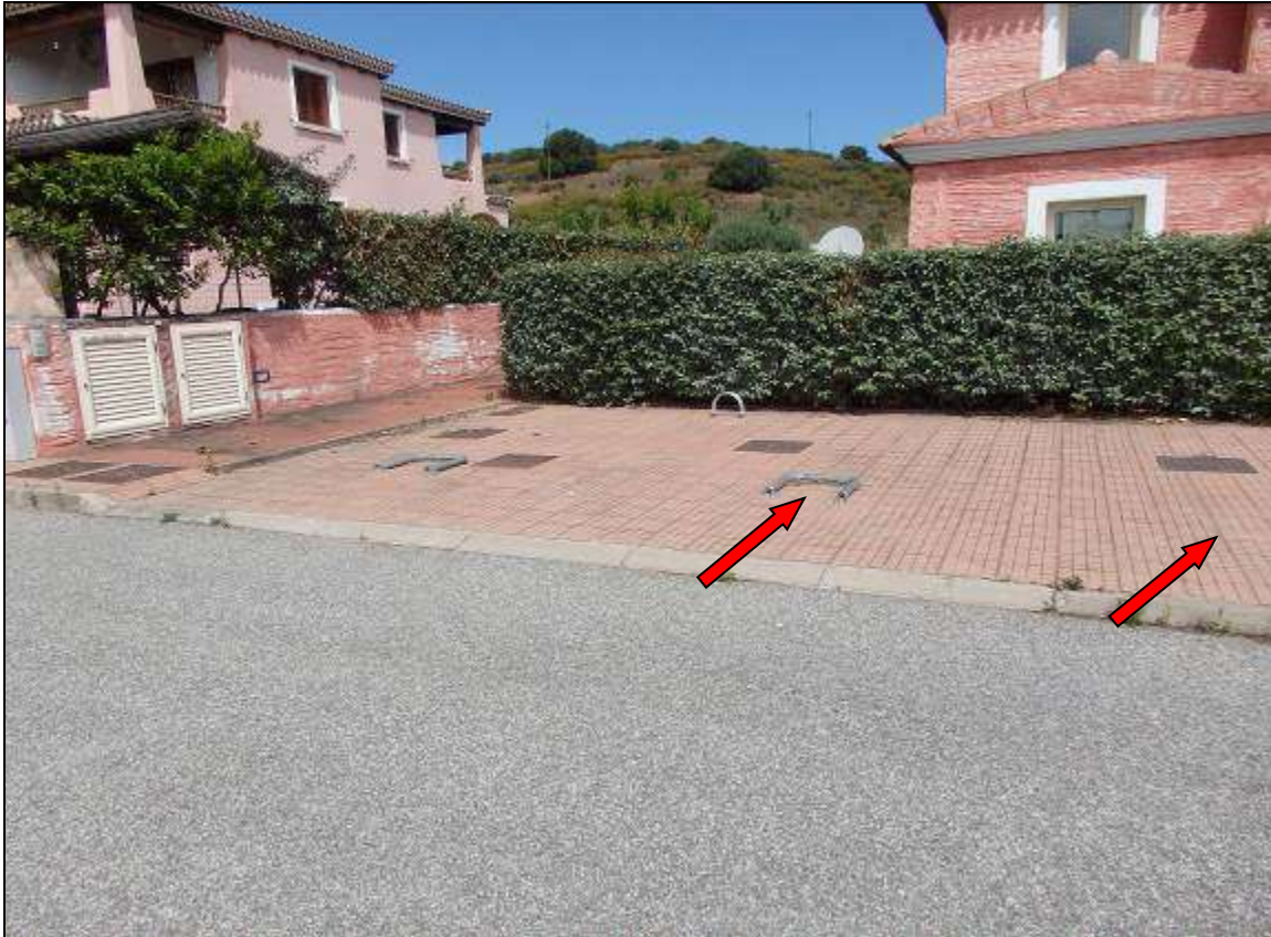
Foto n° 3 – Autorimessa: posto auto (Foglio 237 - Part. 508 – freccia: Sub. 15-16).
