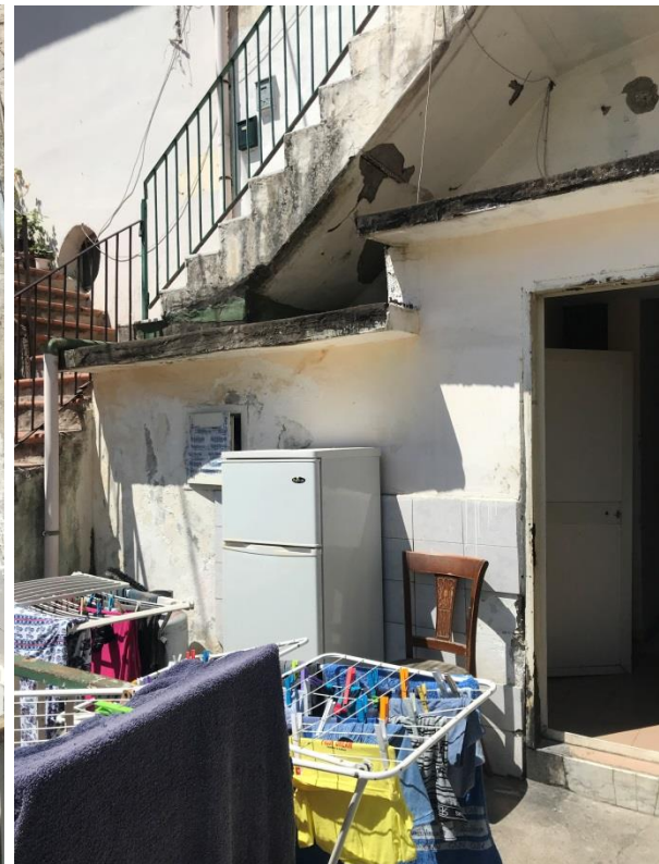
Fotografie n°3 e 4 - Ampliamento esterno sotto la rampa condominiale per ricavarne il bagno ed il disimpegno
