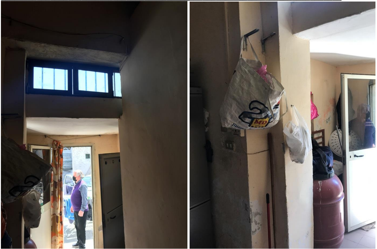
Fotografie n°9 e 10 - Ingresso - Disimpegno
