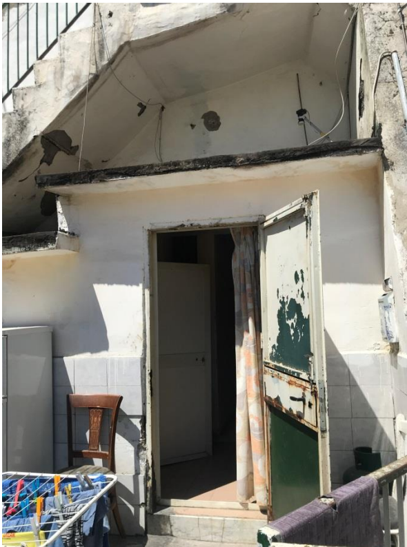
Fotografie n°3 e 4 - Ampliamento esterno sotto la rampa condominiale per ricavarne il bagno ed il disimpegno
